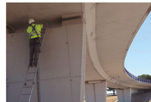
Instalación de un sensor para el control de temperatura y humedad en el interior del hormigón del tablero
