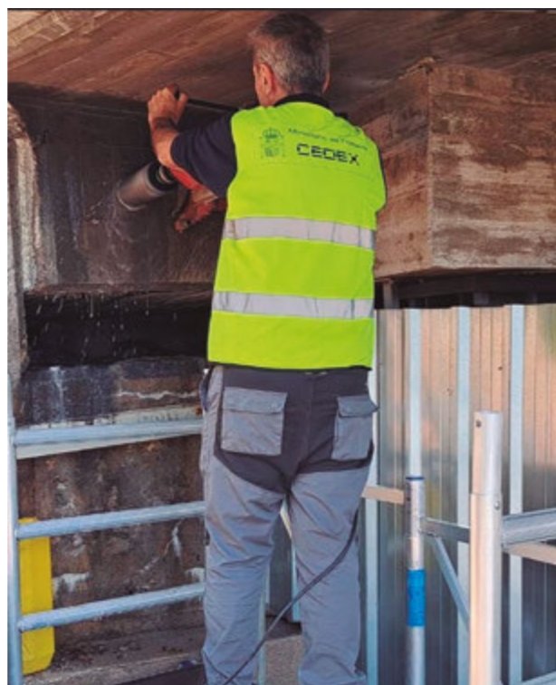
Extracción de testigo en el tablero de un puente
