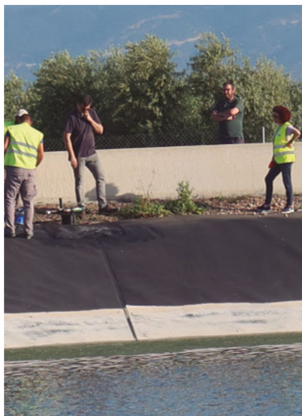
Balsa de acumulación del Sector V-VI. Marmolejo (Jaén)
