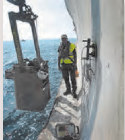
Corrosímetro: medidas in situ .
