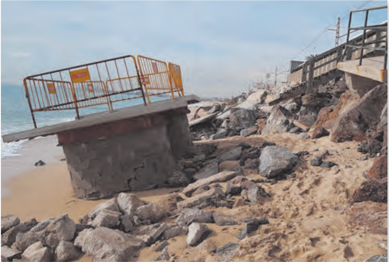
Vista de la erosión de la playa y destrucción del muro costero en Montgat (Barcelona) después del paso de la borrasca Gloria.
