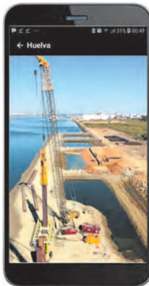
Figura 4. Ampliación del muelle sur del puerto Huelva, mediante tablestacas.
