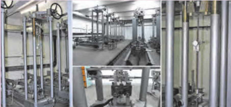
Equipamiento para el ensayo de relajación de aceros.
