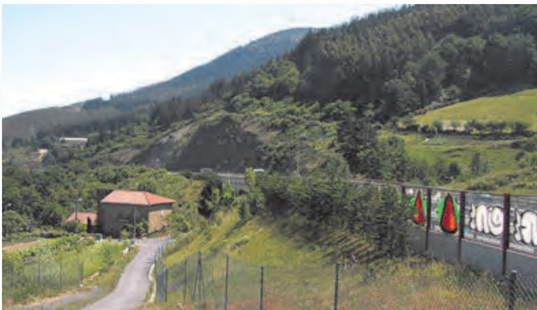
Pantalla acústica en el Corredor del Cadagua, BI-636, en Zamudio (Vizcaya).
