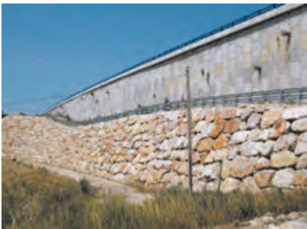
Vista del muro de tierra armada y de escollera junto a la calzada derecha de la BU-30.
