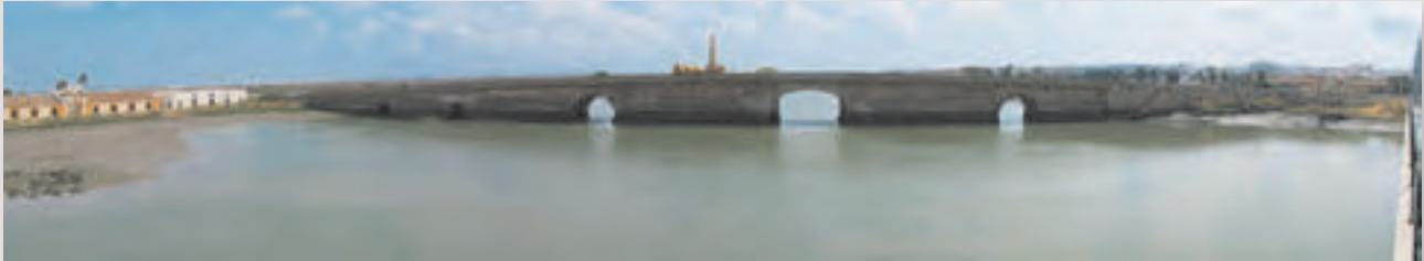
Inspección del puente de Zuazo (Cádiz).
