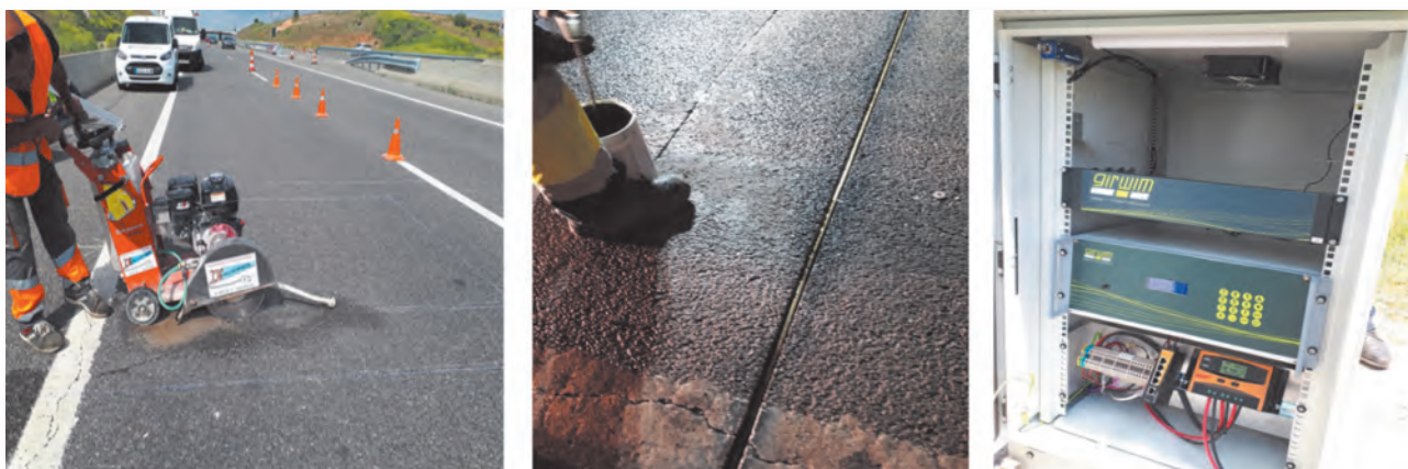
Figura 1. Ejecución del corte del pavimento con sierra de diamante para excavar las rozas donde se introducen los sensores. Aspecto del sensor piezopolímero colocado en la roza. Armario que aloja los equipos electrónicos que rigen el funcionamiento del sistema.
