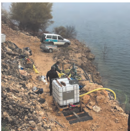
Ejecución del ensayo, alberca de 1 x 1 m.
