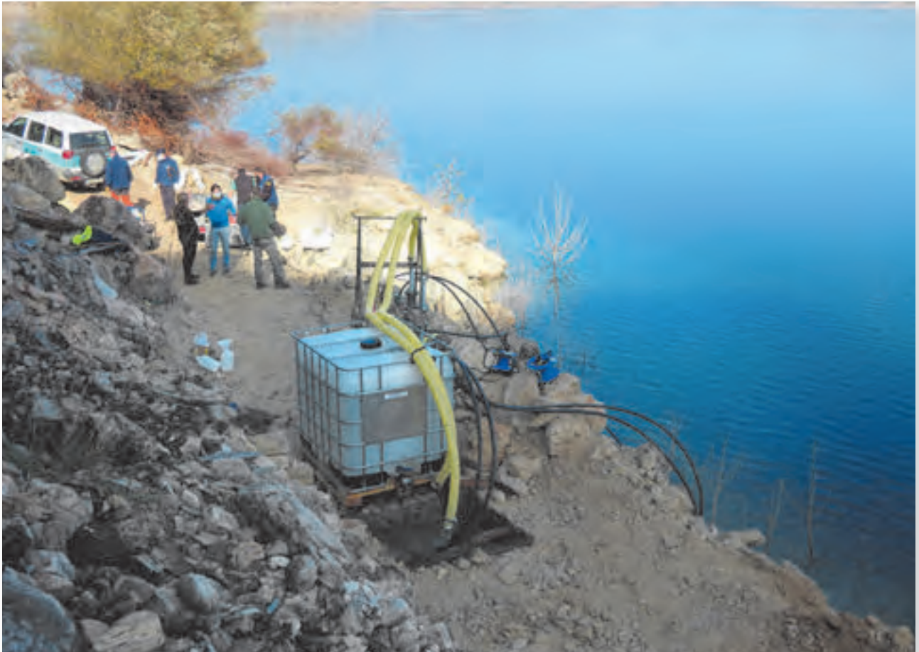
Figura 6. Ensayo de permeabilidad a gran escala (presa de Alcorlo, espaldón de aguas arriba).
