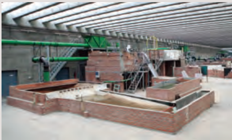
Vista general de la Nave I (izquierda) y de la Nave II (derecha).
