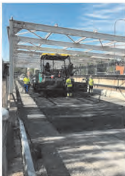
Extendido mezclas bituminosas.
