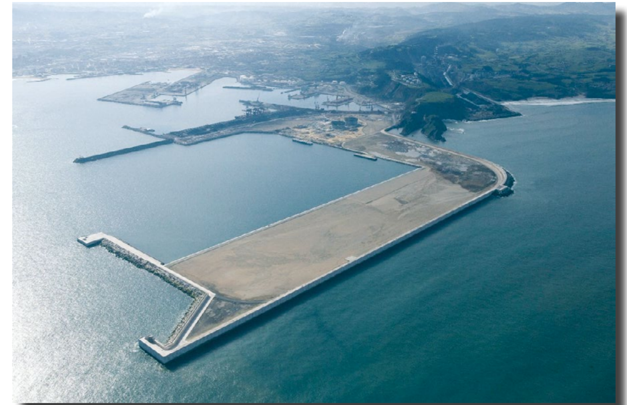
Figura 5. Proyecto de acceso ferroviario al muelle norte (puerto de Gijón). Vista aérea de muelle.
