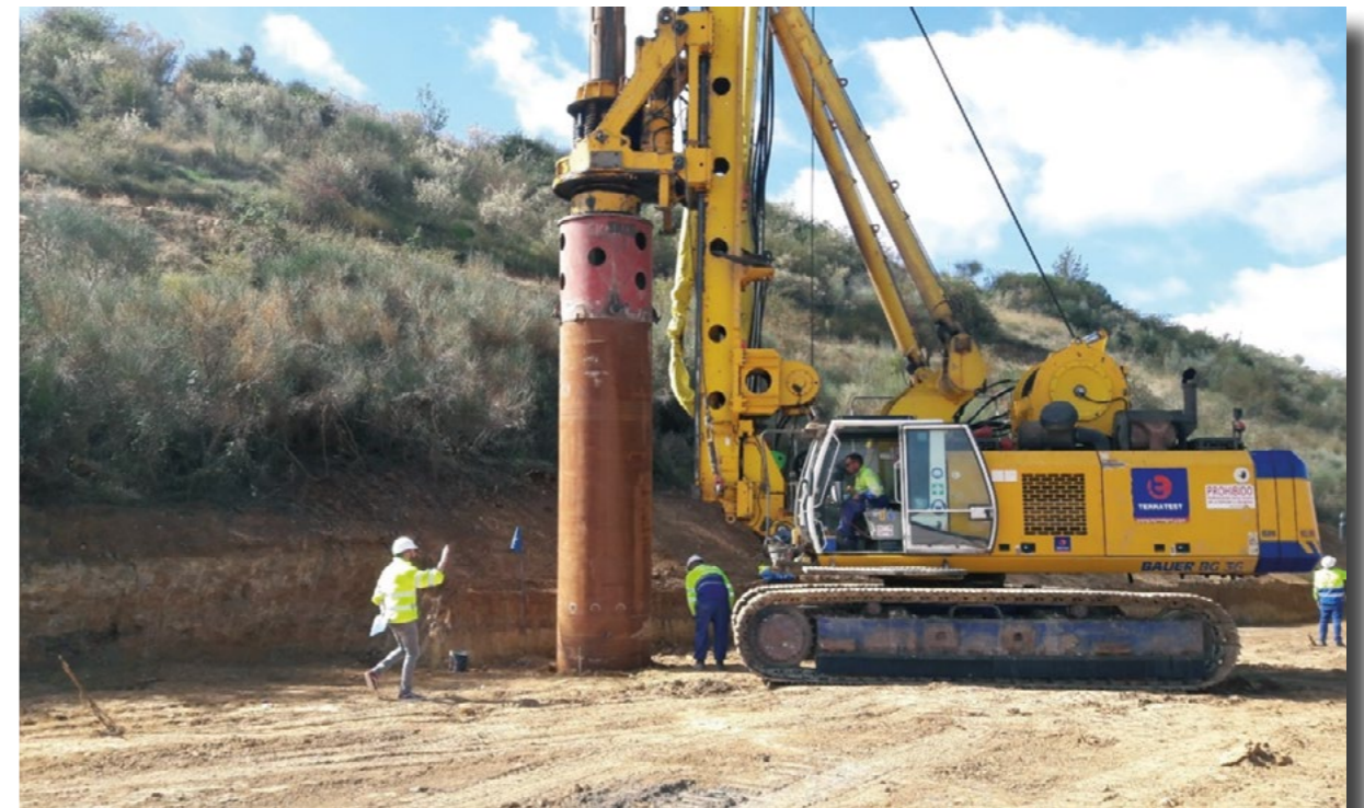
Ejecución de pantalla de pilotes para la corrección de la inestabilidad.
