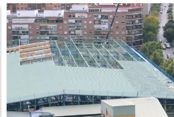
Nave de ensayos en fase de reconstrucción de la cubierta (2022).
