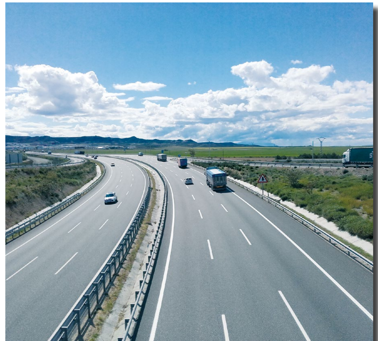
Concesión de la A-2 en la provincia de Zaragoza.
