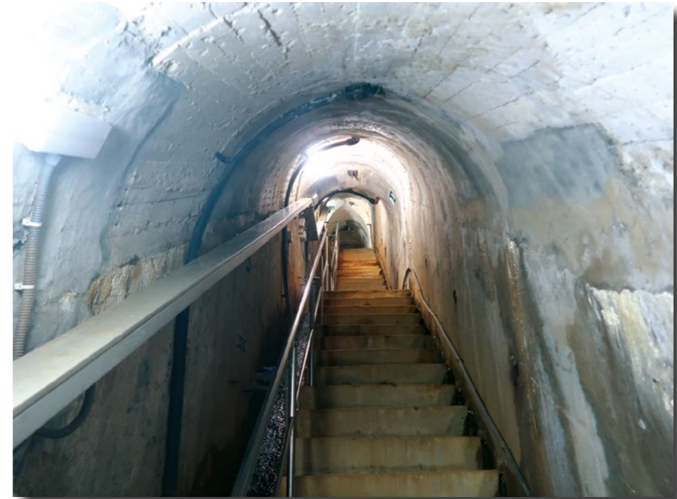
Galería de la presa.
