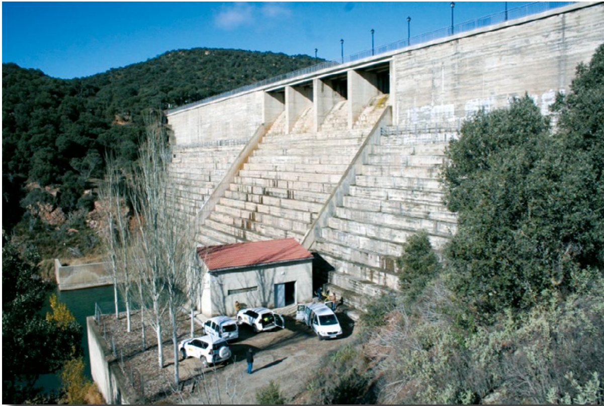
Figura 6. Caracterización del cemento en el estribo izquierdo de la presa de El Atance.
