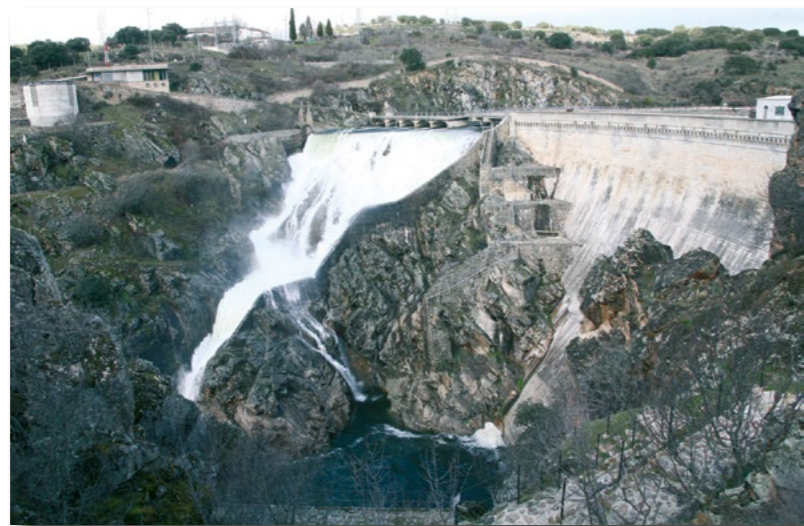
Aliviadero de la presa de El Villar.
