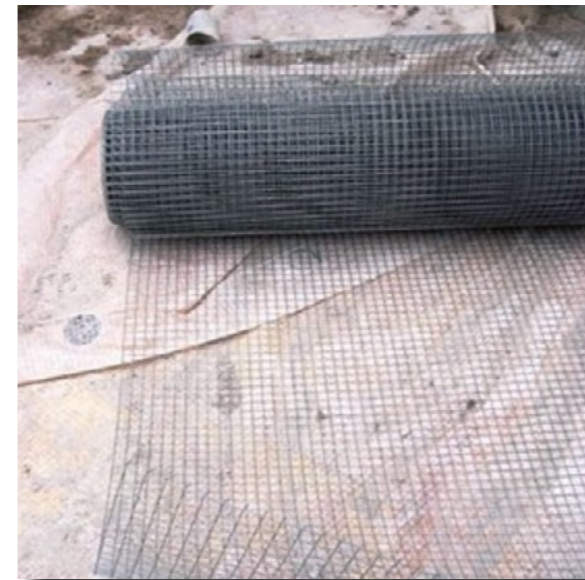
Armaduras de acero galvanizado y GFRP.
