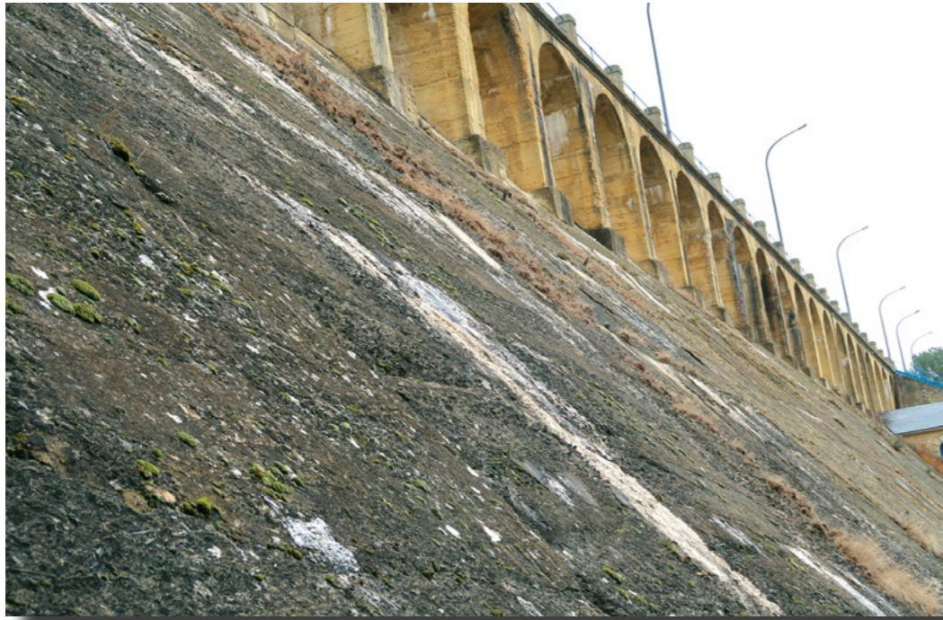
Estudio del hormigón de la presa de Villameca.
