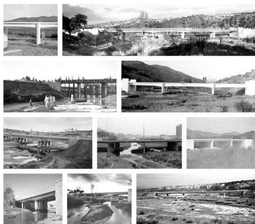
Colección de imágenes de distintos puentes de altura estricta del Fondo Documental Carlos Fernández Casado, CEHOPU-CEDEX.
