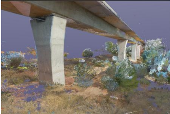
Generación de nube de puntos del viaducto del proyecto ERJU
