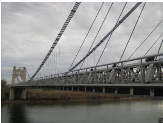
Puente de Amposta
