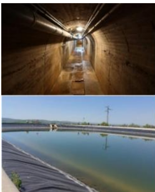
Galería de la presa de Bárcena (superior) y Balsa del Sector III Villanueva-Espeluy
