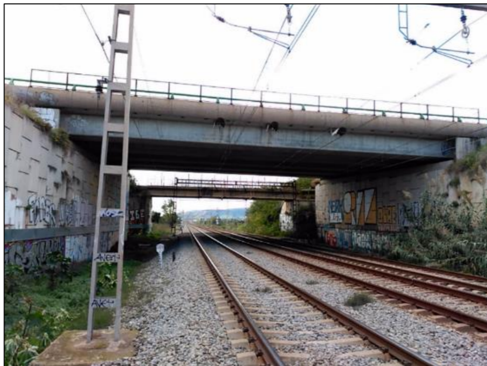
Figura 24. Viaducto de la autovía B-22.
