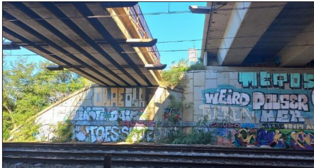
Figura 26. A la izquierda, paso superior camino de Can Casanoves, con limitaciones de gálibo vertical. A la derecha, viaducto B-22.
