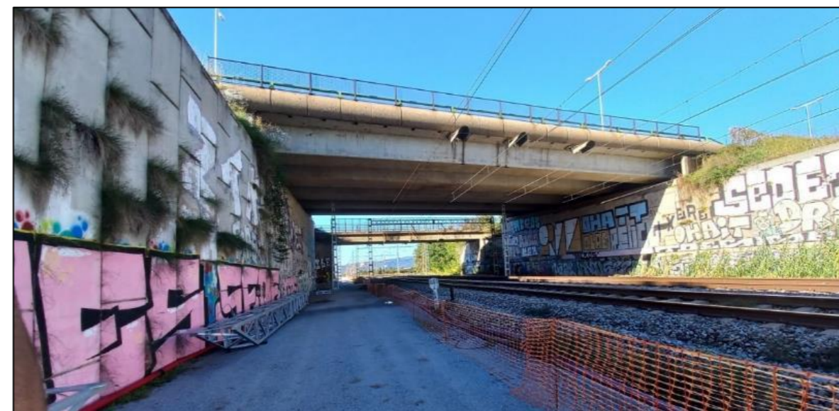
Figura 25. Viaducto de la autovía B-22, en la que se observan labores de plataforma para la vía 4.
