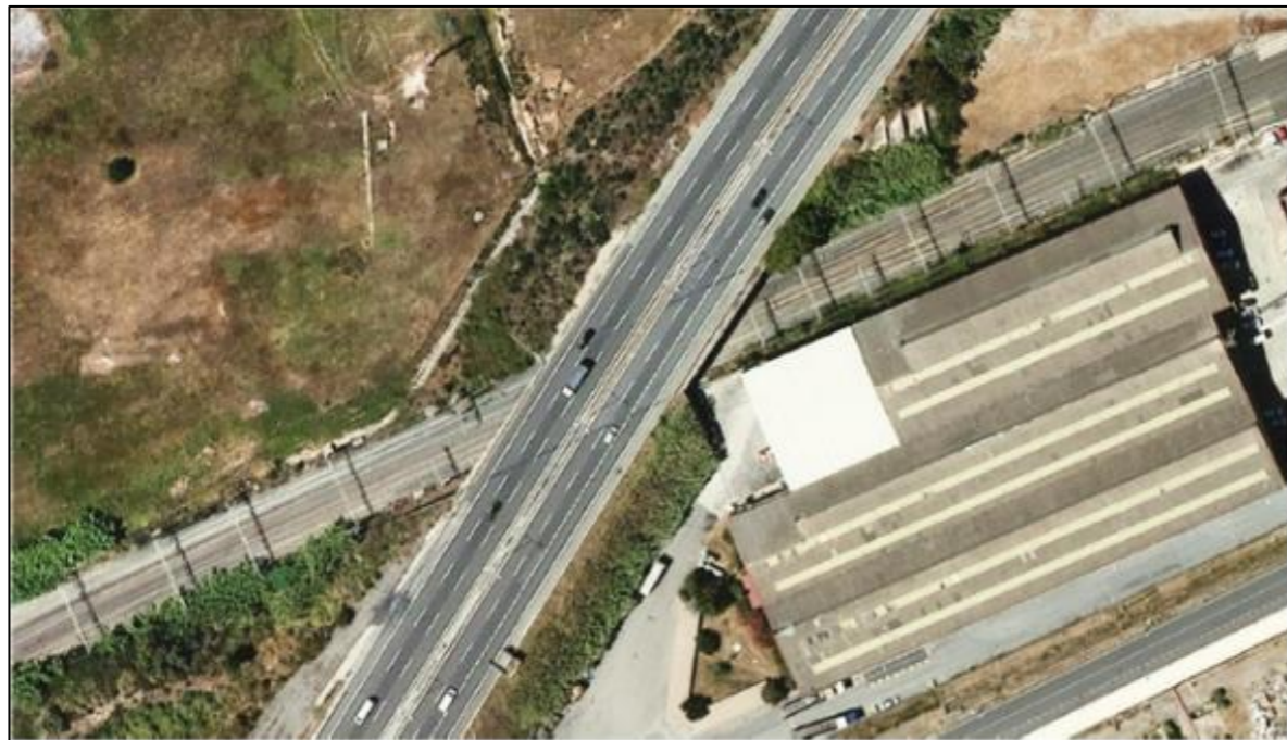
Figura 23. Paso superior de la autopista C-31.
