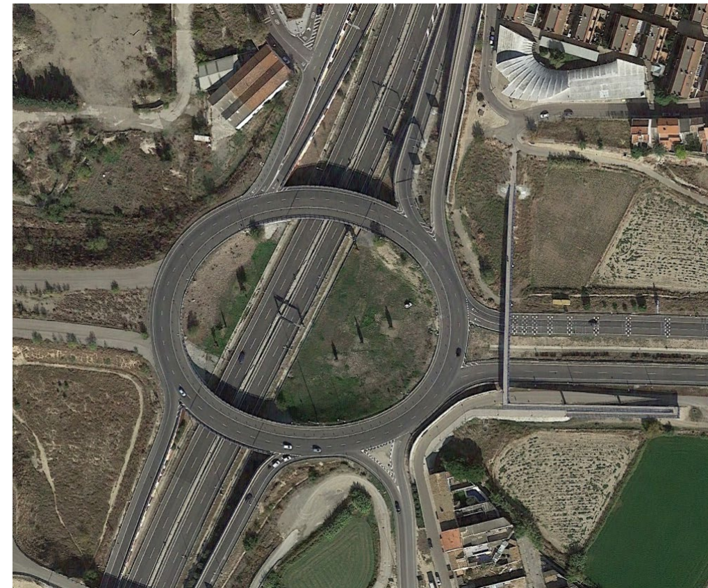
Glorieta sobre Z-40 donde conecta la N-II y la CV-314 en el mismo cuadrante
