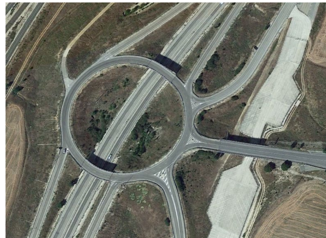
Glorieta sobre A-1 donde conecta la N-I y la conexión a la AP-1 en el mismo cuadrante
