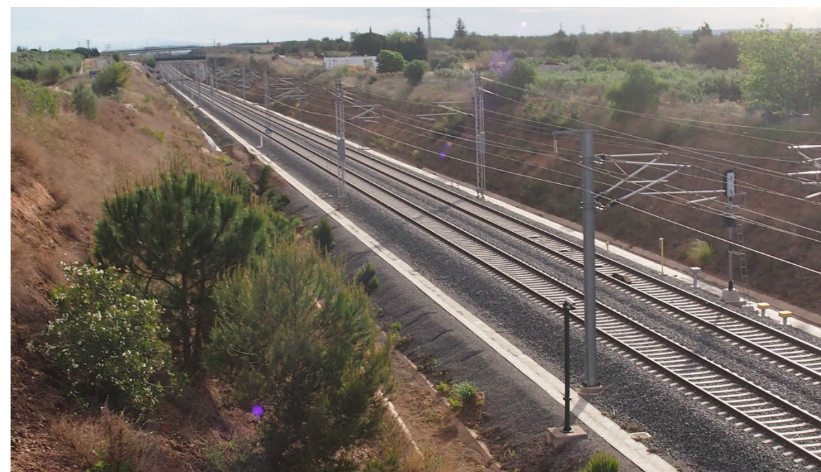
Ámbito de inicio de proyecto, vía mango 1 y 2
