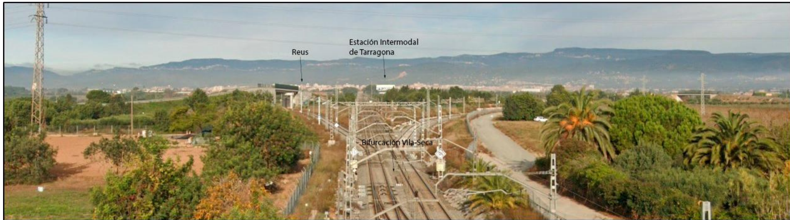
Panorámica con actuaciones desde punto de observación 1. Fuente: Elaboración propia.
