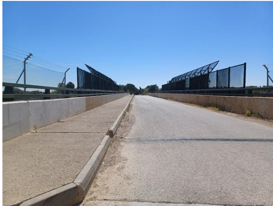
Paso superior con vallado antivandálico. Fuente: elaboración propia.
