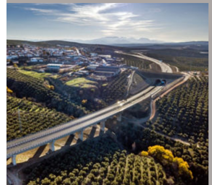
Fig.97 La A-32 pone fin al paso por el centro de Villacarrillo
