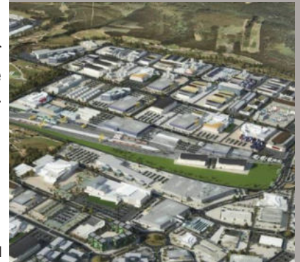
Fig.56 Urbanización Zalia fase 1 en Gijón, Asturias
