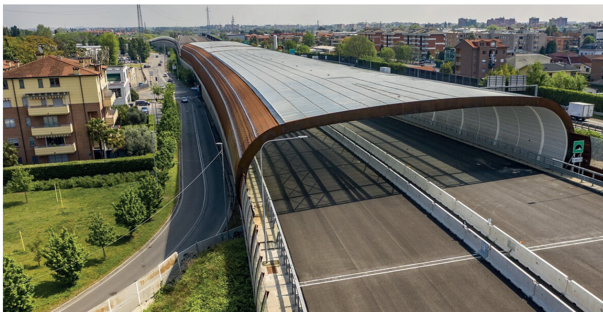
Figura 45: Cubierta total de la vía en Italia.
