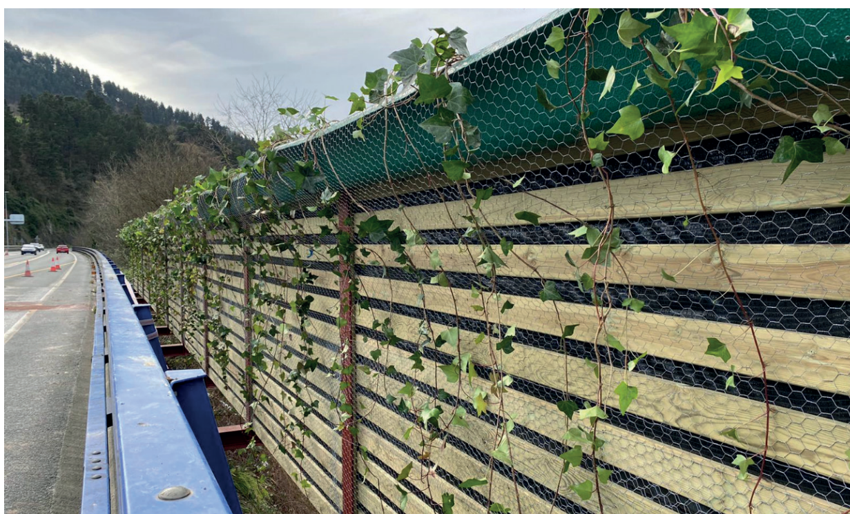
Figura 42: Vista de un difractor-jardinera después de su instalación sobre una pantalla de madera.
