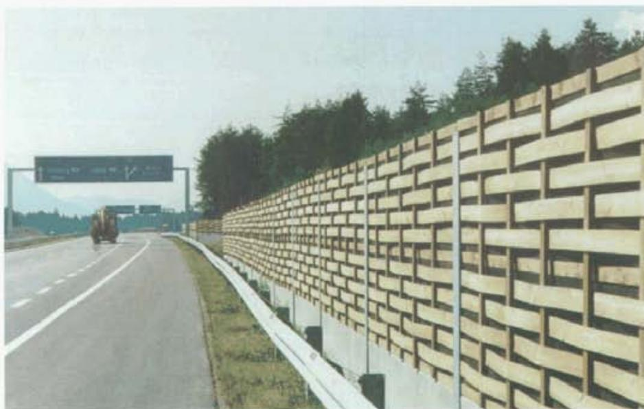
Los materiales empleados en la construcción de muros anti-ruido son los siguientes: madera (55%), metal (sobre todo aluminio)(20%), hormigón (bloques moldeables)(10%), vidrio (5%), material sintético o vidrio acrílico (5%), barreras de seguridad en hormigón acrílico (5%) y barreras de seguridad en hormigón (New Jersey)(5%).
