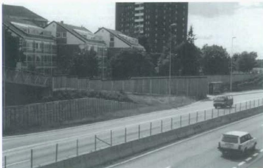
**Figura 4.12. Reducción del ruido en un tramo en trinchera con muros verticales absorbentes (comparado con un tramo en trinchera no tratado, ref. 1).**
