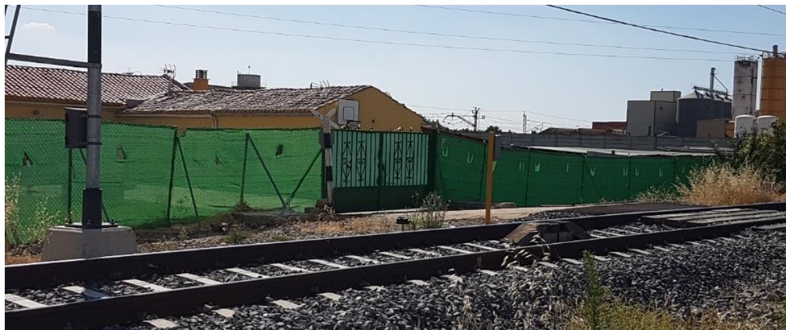
Paso a Nivel existente, que da acceso a las edificaciones situadas entre las vías.
