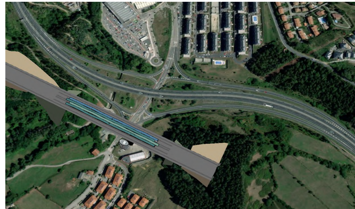
Figura 32. Vista superior de la estación de Castro-Urdiales (Variante Baja)
