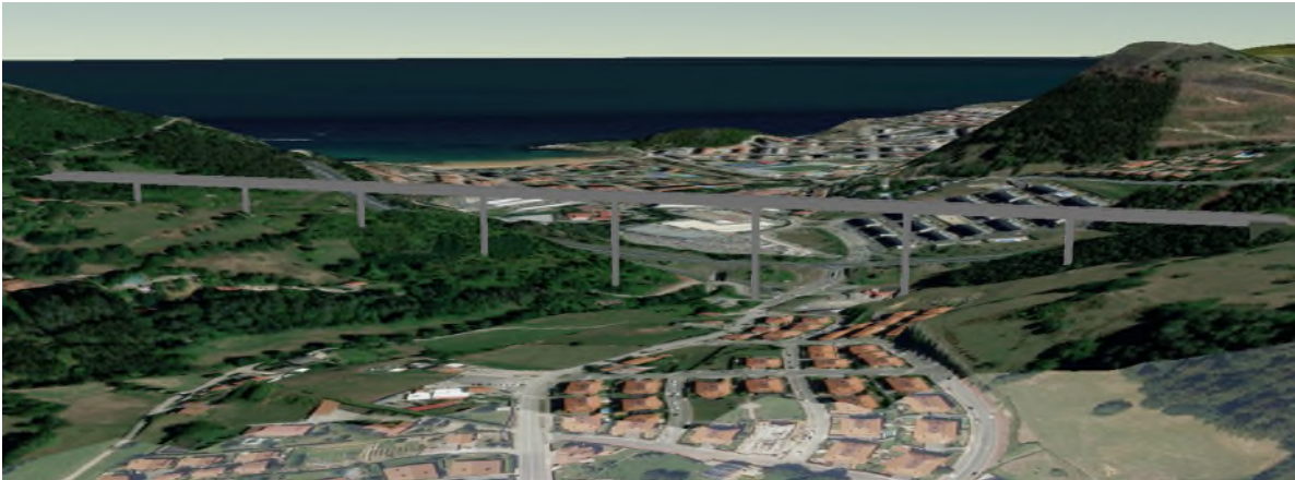
Figura 42. Vista lateral del viaducto de Castro-Urdiales (Variante Alta)
