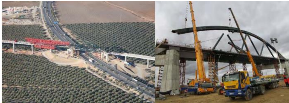
Figura 7. Montaje de arco con grúa
