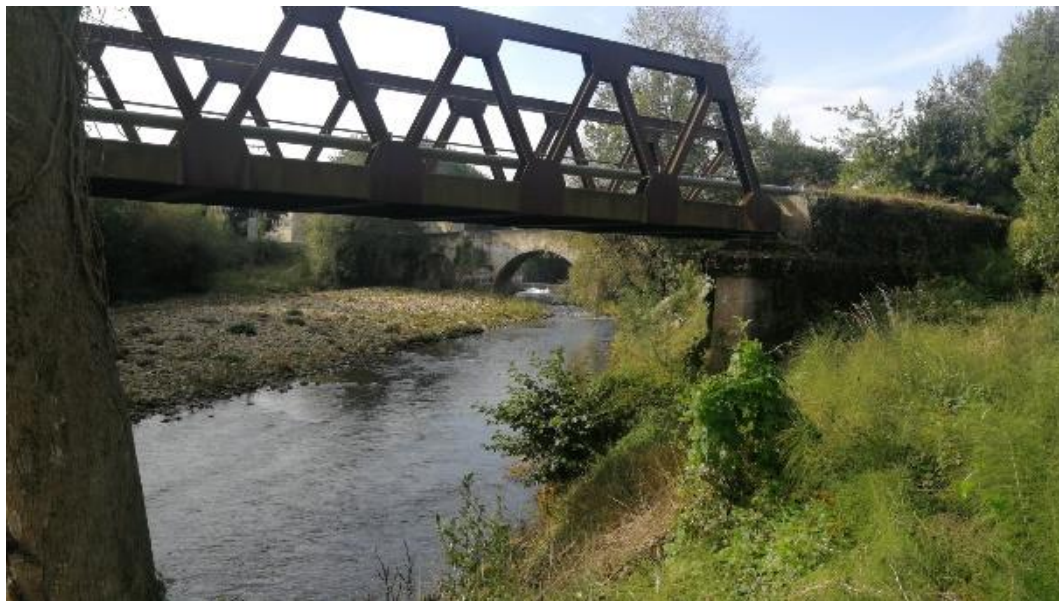
Fotografía 4. Figura 23. Puente de FFCC.
