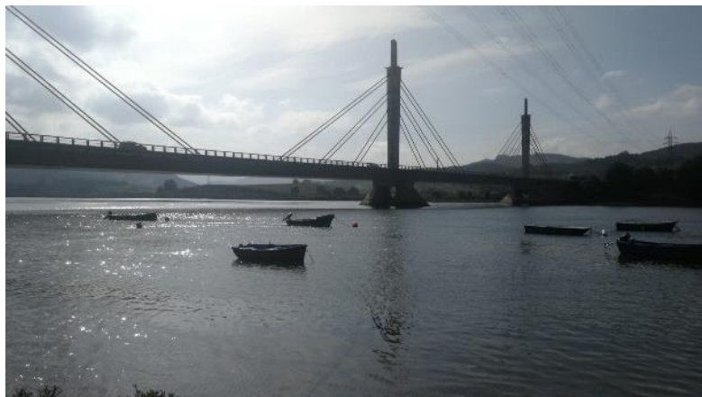
Figura 34. Fotografía 17. Viaducto de la A-8 sobre la ría de Treto.
