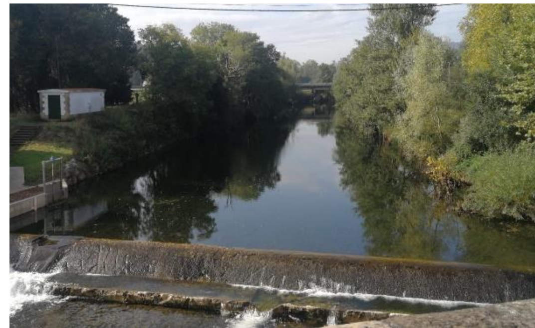
Fotografía 6. Presa aguas arriba del puente de piedra.
