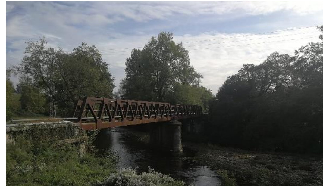
Fotografía 5. Puente del ferrocarril sobre el río Miera.
