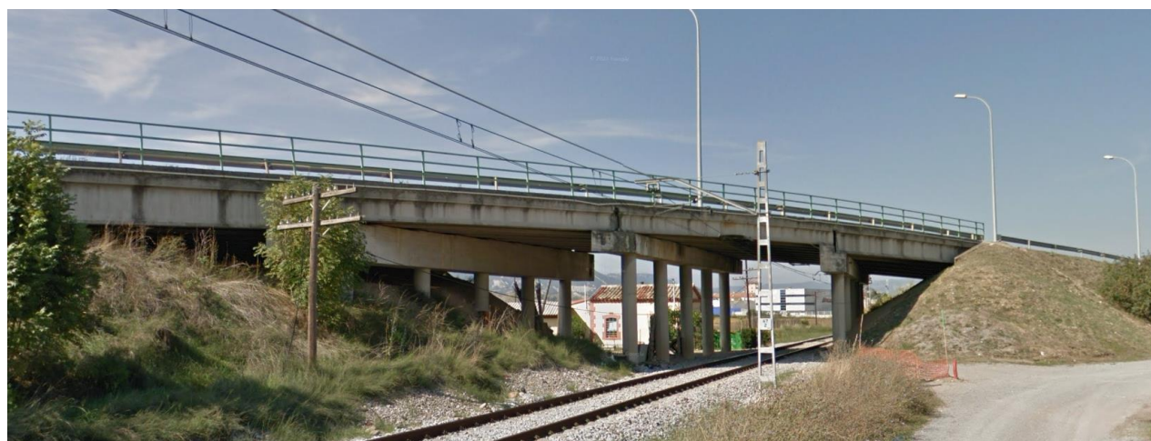
Figura 5. Paso superior situado en el P.K. 67+239. Para aprovechar la estructura existente, la duplicación de vía tendrá que discurrir por el vano central izquierdo
