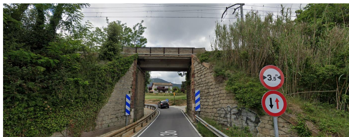
Figura 2. Paso inferior existente en la carretera C-1413b. Con el fin de no producir un estrangulamiento en la carretera, lo más razonable sería construir una nueva estructura de vía doble.
