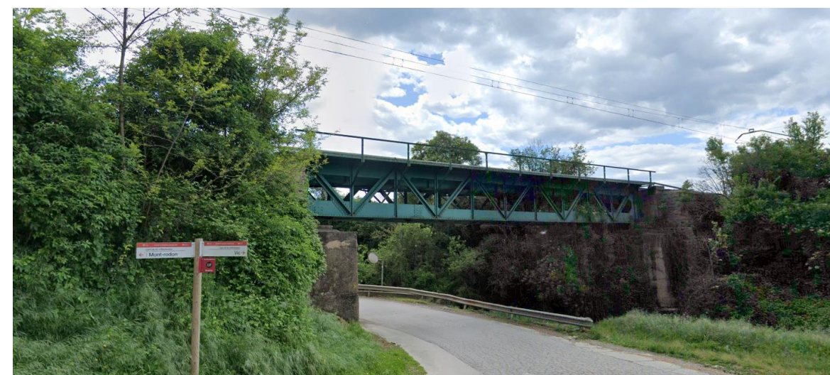
Figura 4. Viaducto existente en el P.K. 64+800 que salva una carretera local y la Riera de Tona.
