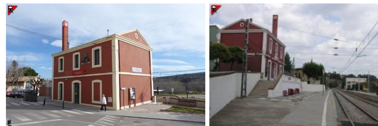
Edificio de viajeros de la estación de Centelles
