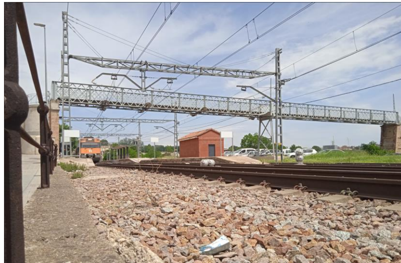
Pasarela peatonal urbana existente
