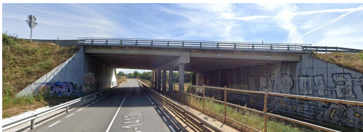
Figura 1. Paso superior de la autovía C-17. Esta estructura es adecuada para permitir la duplicación de vía junto al estribo sur
