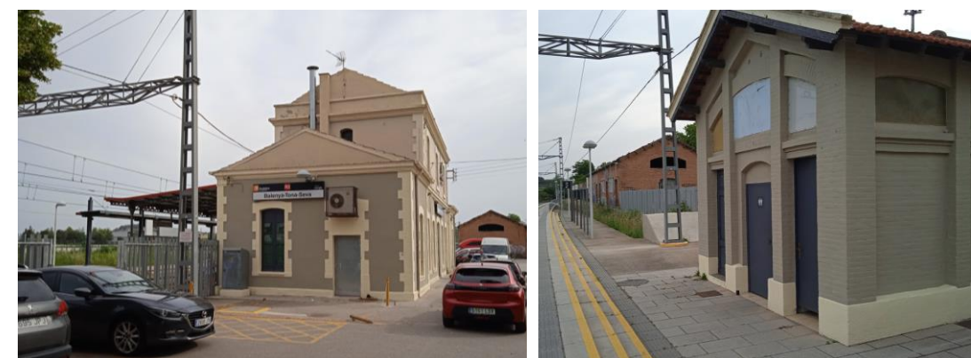
Fotografía 4. Imágenes de la estación de Balenyà-Tona-Seva
