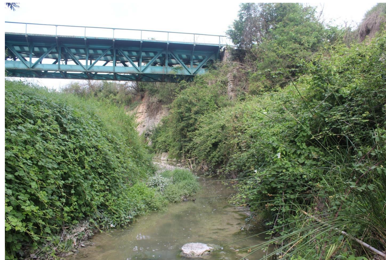
Fotografía 9. Torrent de Sant Cugat o riera de tona (jerarquía 3) en la zona de cruce donde se proyecta la sustitución del viaducto (VD-64+750) (alternativas 1 y 2).
