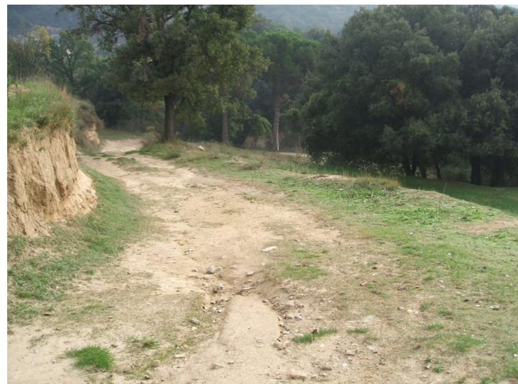
Fotografía 7. Pequeño desmonte excavado en materiales aluviales de la Unidad Q Ac en los alrededores de Centelles.
