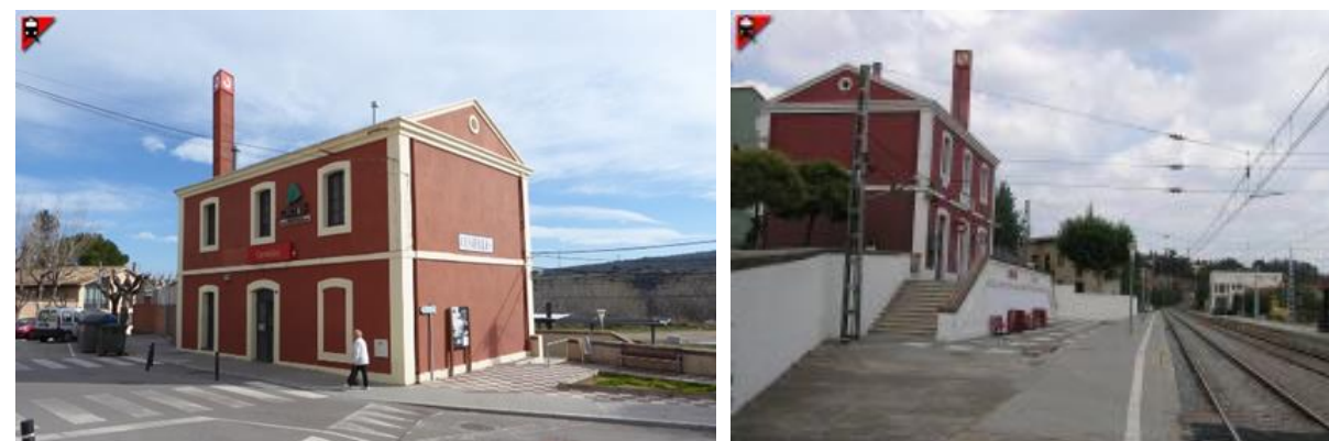
Fotografía 1. Edificio de viajeros de la estación de Centelles
