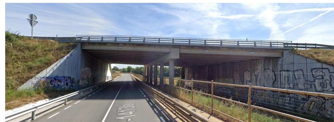
Figura 5. Paso superior de la autovía C-17. Esta estructura es adecuada para permitir la duplicación de vía junto al estribo sur
