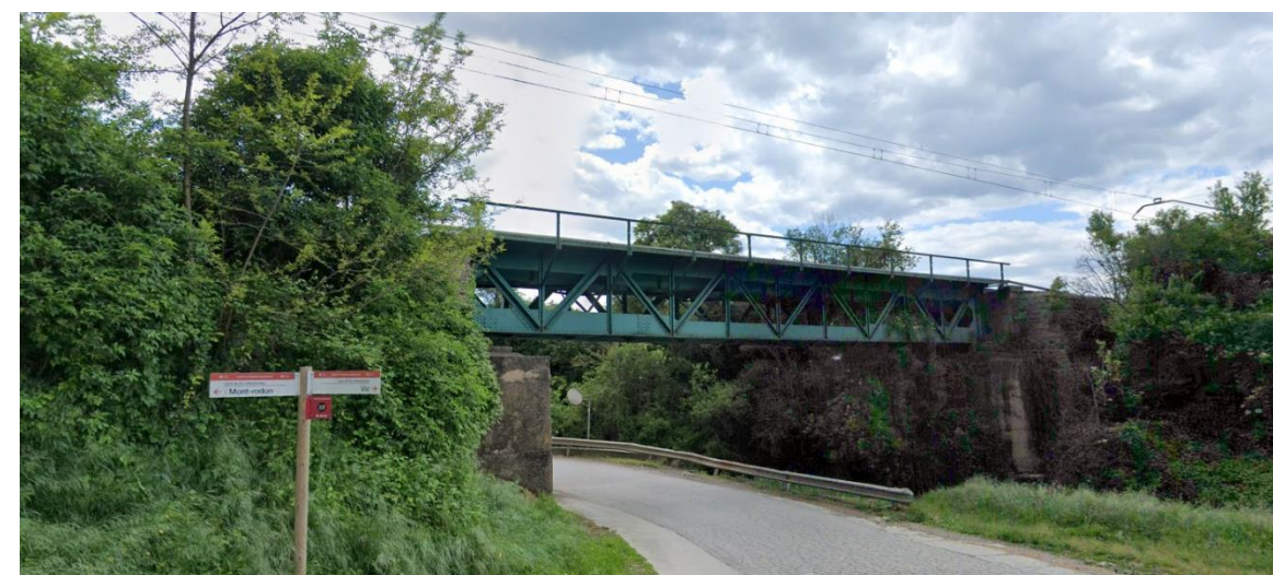
Figura 8. Viaducto existente en el P.K. 64+800 que salva una carretera local y la Riera de Tona.
