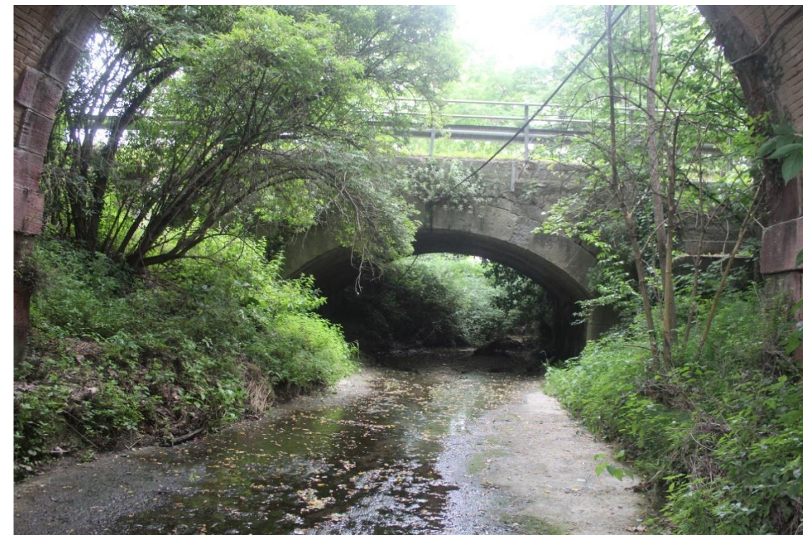
Fotografía 22. Estructura de drenaje de la carretera BV-5305 de Taradell a Balenyà y paralela a la actual vía de ferrocarril.
