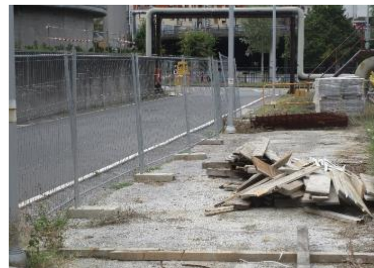
Figura 101. Vallado perimetral reforzado.
