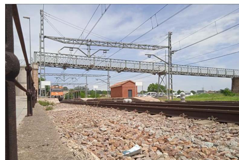
Fotografía 2. Pasarela peatonal urbana existente
