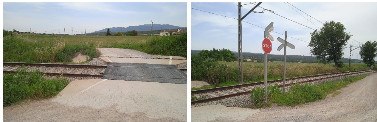
Fotografía 5. Imágenes del paso a nivel existente en el PK 57+313 de la vía actual.
