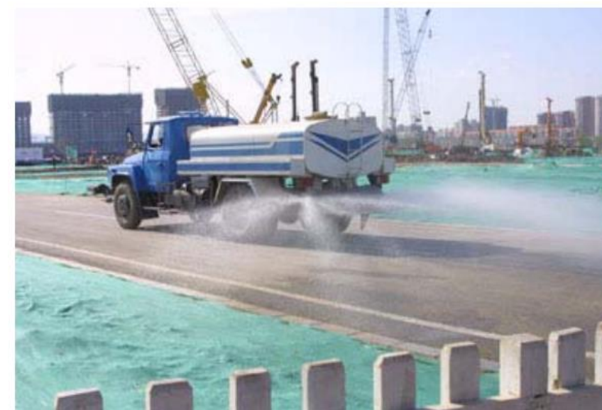
Figura 108. Riegos superficiales de los viales y caminos utilizados durante la ejecución de las obras.
