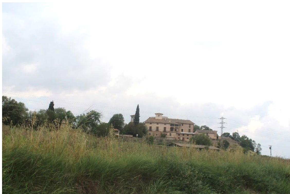
Fotografía 30. Masia Torrellebreta (bien arquitectónico) en el municipio de Malla.
