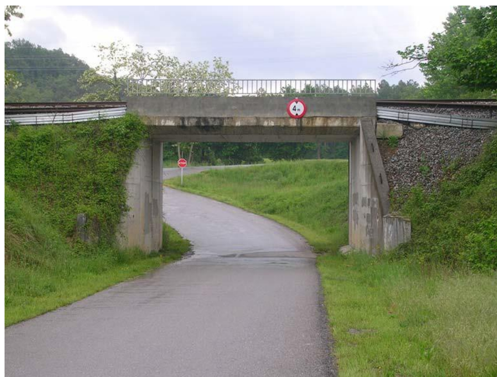
Fotografía 19. Paso inferior en el municipio de Seva.
