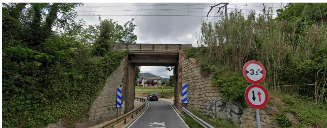
Figura 6. Paso inferior existente en la carretera C-1413b. Con el fin de no producir un estrangulamiento en la carretera, lo más razonable sería construir una nueva estructura de vía doble.
