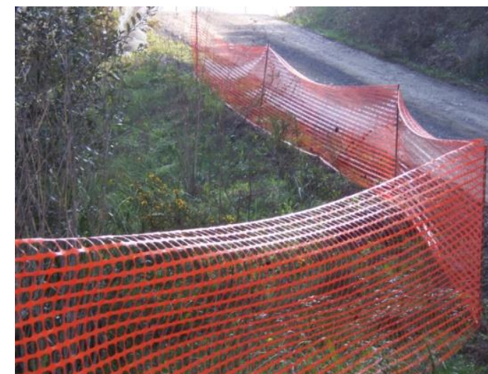
Figura 102. Vallado de protección de valores ambientales mediante malla plástica.
