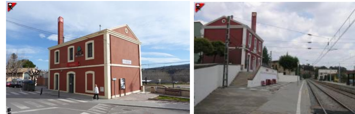
Figura 25. Edificio de viajeros de la estación de Centelles
