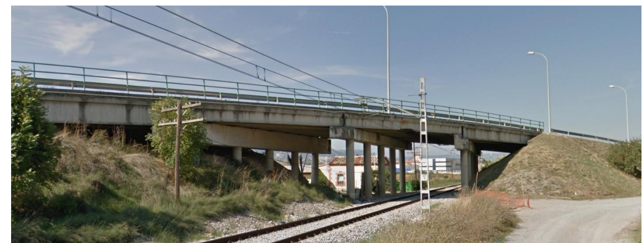
Figura 21. Paso superior situado en el P.K. 67+239. Para aprovechar la estructura existente, la duplicación de vía tendrá que discurrir por el vano central izquierdo
