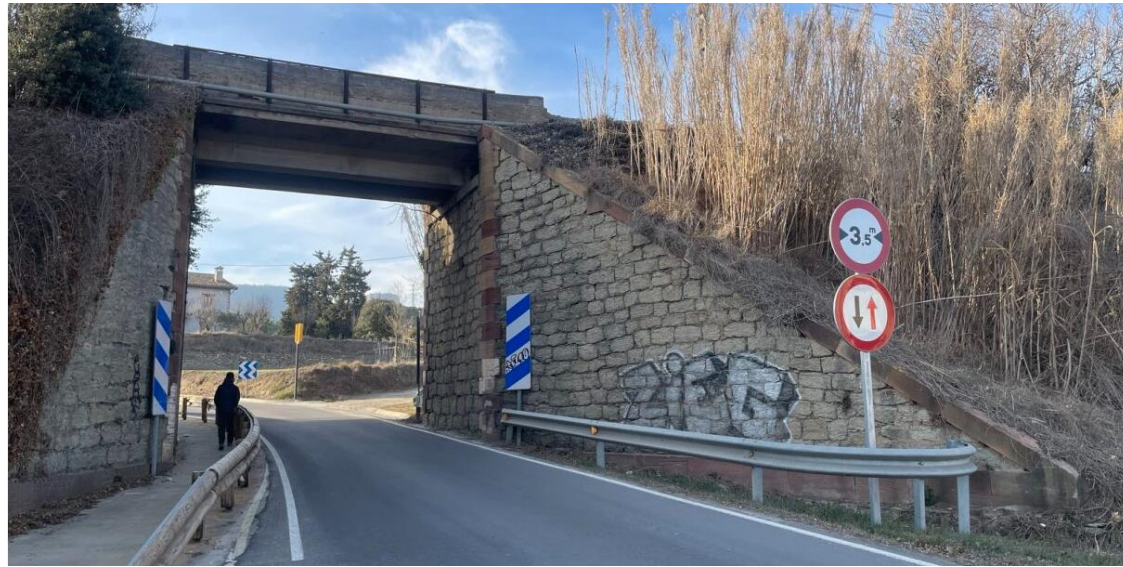
Figura 18. Paso inferior existente en la carretera C-1413b. Con el fin de no producir un estrangulamiento en la carretera, lo más razonable sería construir una nueva estructura de vía doble.
