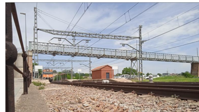
Figura 26. Pasarela peatonal urbana existente
