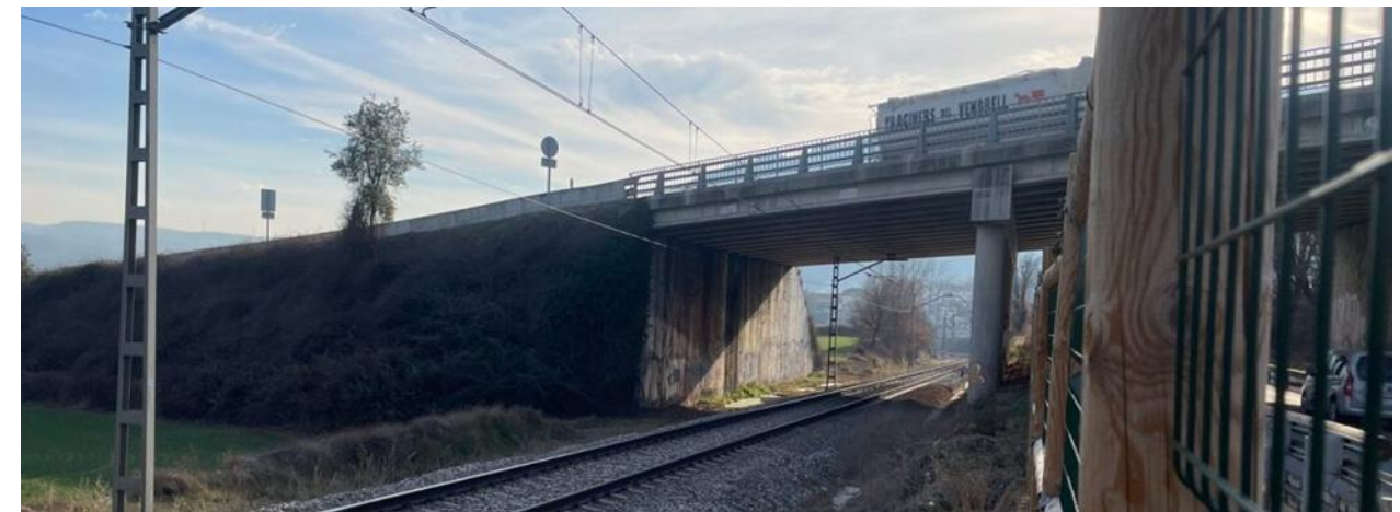
Figura 17. Paso superior de la autovía C-17. Esta estructura es adecuada para permitir la duplicación de vía junto al estribo sur
