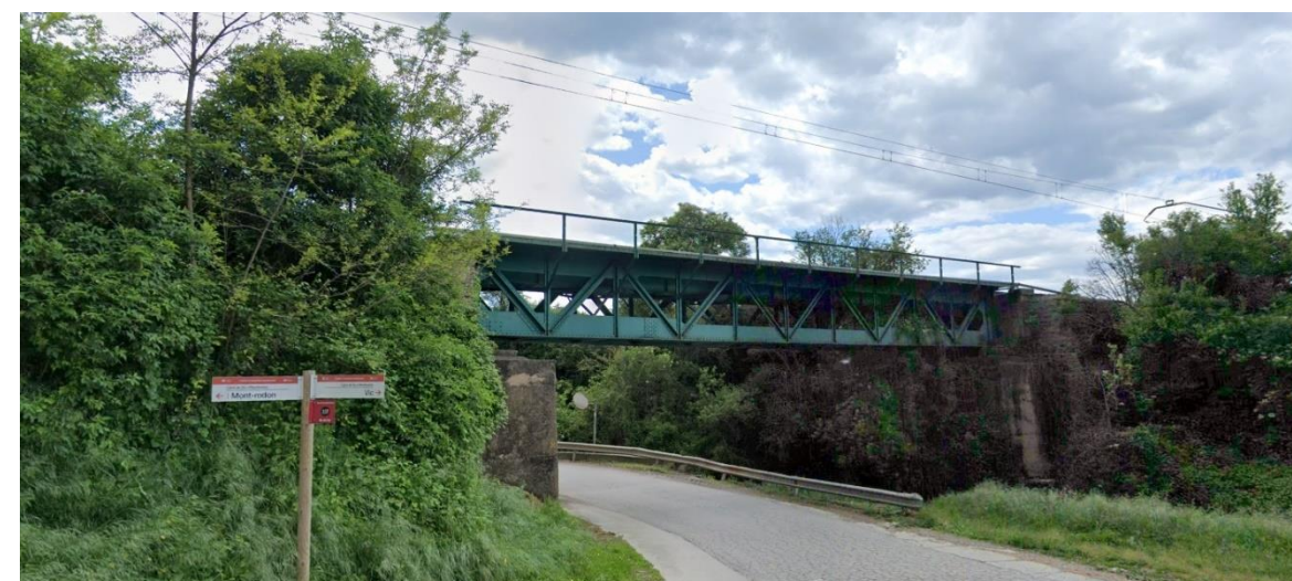
Figura 8. Viaducte existent al PK 64+800, que travessa una carretera local i la riera de Tona.
