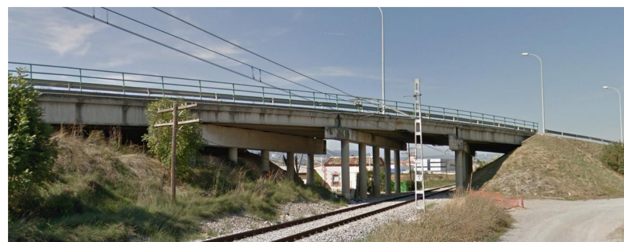
Figura 9. Paso superior situado en el P.K. 67+239. Para aprovechar la estructura existente, la duplicación de vía tendrá que discurrir por el vano central izquierdo
