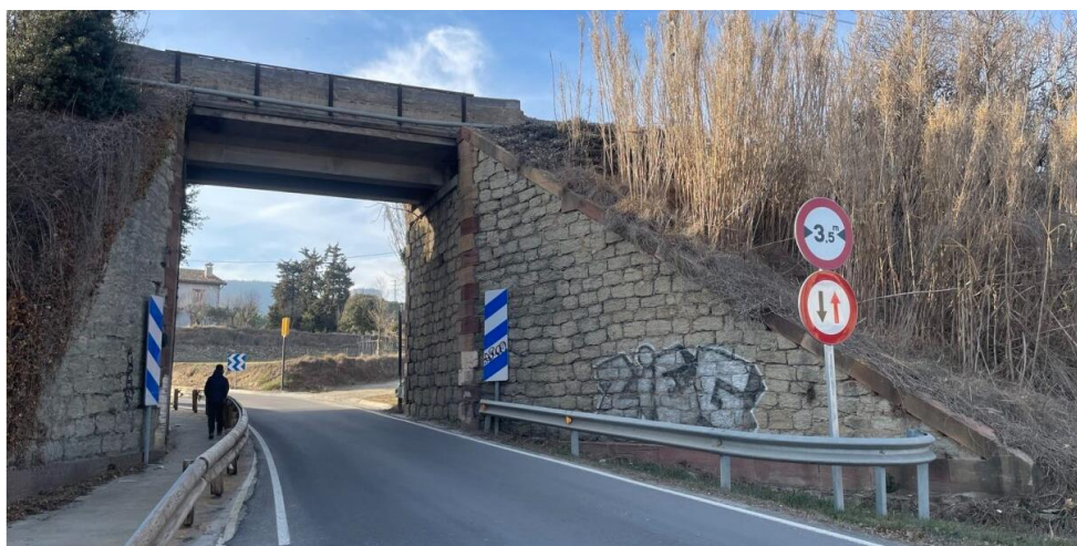
Figura 6. Paso inferior existente en la carretera C-1413b. Con el fin de no producir un estrangulamiento en la carretera, lo más razonable sería construir una nueva estructura de vía doble.
