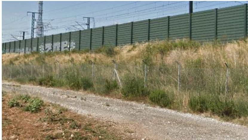
Figura nº 21. Estructura E2. Cajón empujado. Pantallas acústicas existentes
