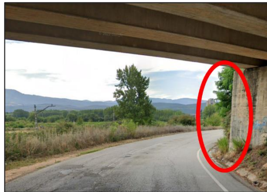
Estribo de la estructura existente sobre la carretera LE-5206.
