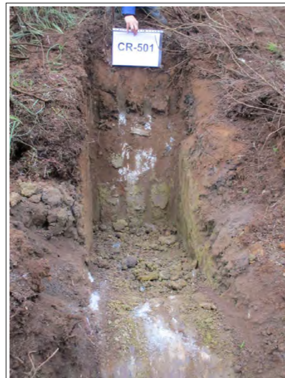
Aspecto de la excavación
