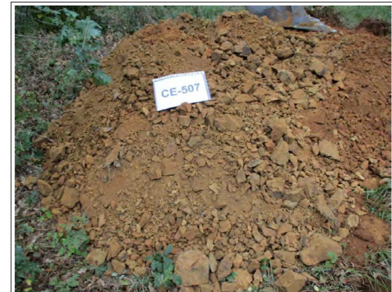
Detalle del material excavado
