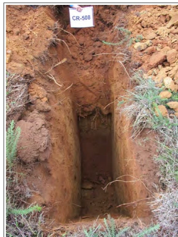
Aspecto de la excavación
