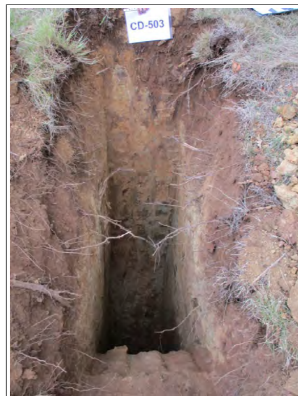
Aspecto de la excavación
