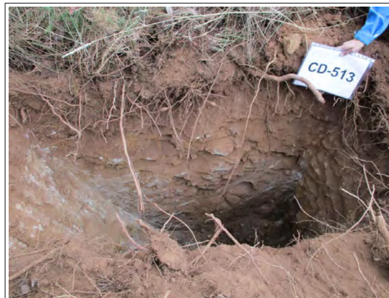
Vista pared lateral de la calicata
