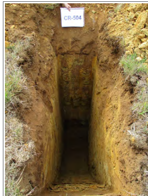
Aspecto de la excavación
