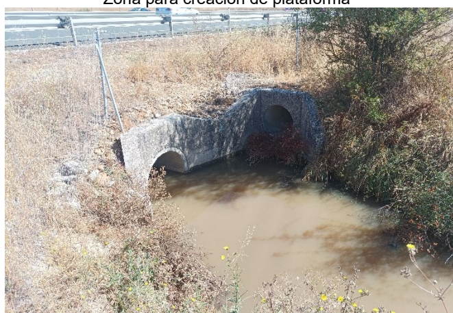
Drenaje actual de autopista y cauce de arroyo actual
