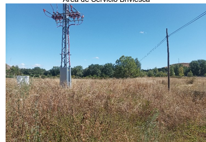
Torre de Alta Tensión y Red aérea de teléfono próximas a la actuación
