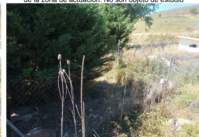
Arquetas próximas a depósito. Levantamiento de estas a cota durante la actuación
