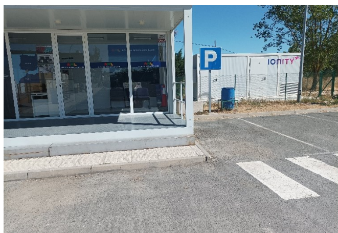
Caseta prefabricada de venta de tickets e instalaciones de Ionity objeto de reubicación
