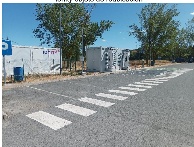
Aparcamiento actual. La zona de la izquierda dará acceso al nuevo aparcamiento de emergencia
