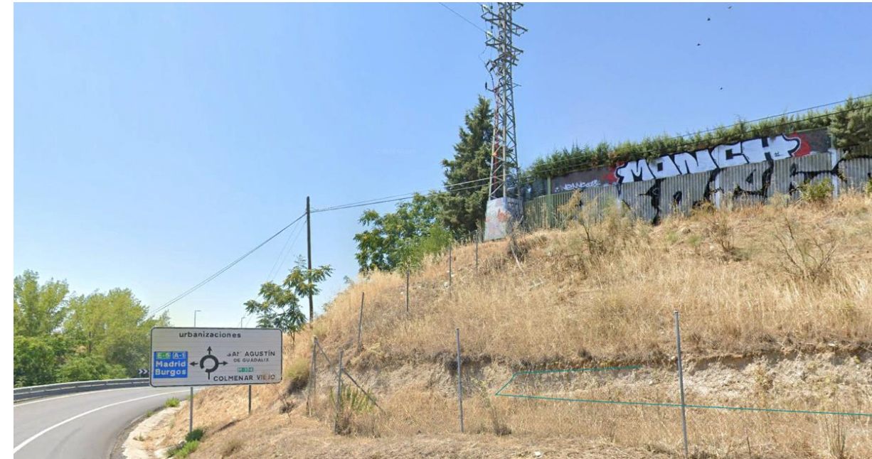
Fotografía 31. PT-16. Torre eléctrica condicionante del trazado
