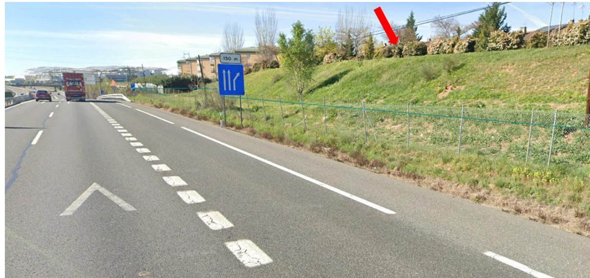
Fotografía 33. PT-17. Coronación de talud en que irá ubicada
