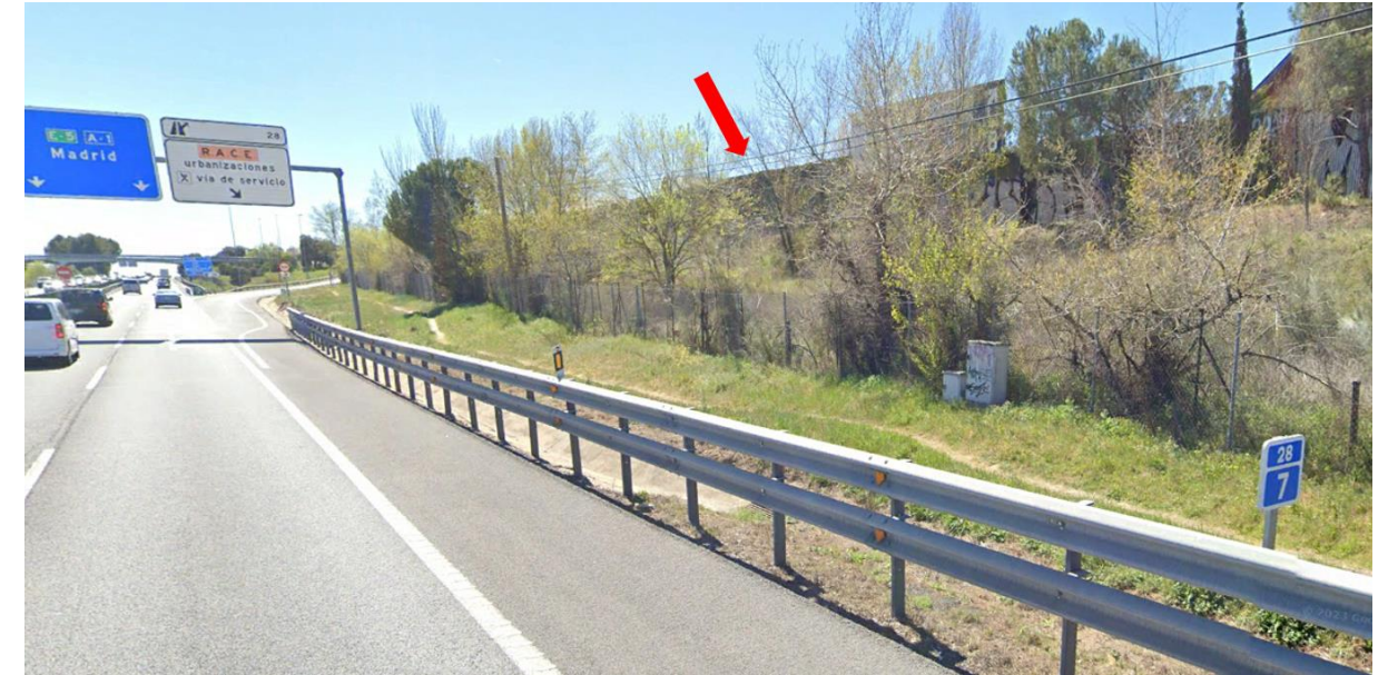
Fotografía 18. PT-12. Pantalla acústica obsoleta a la que discurrirá paralela
