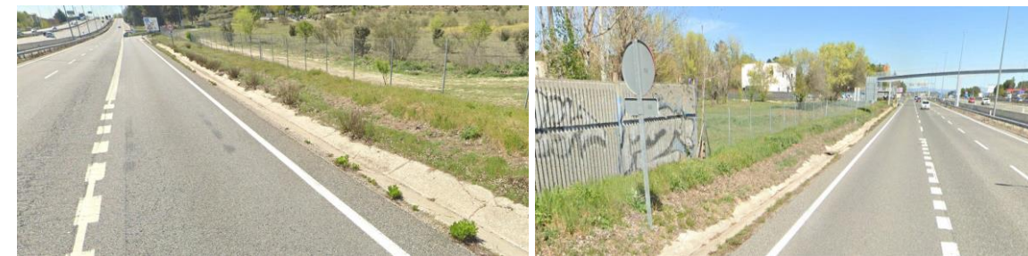
Fotografía 1. PT-1. Tramos inicial e intermedio sin pantalla actualmente
