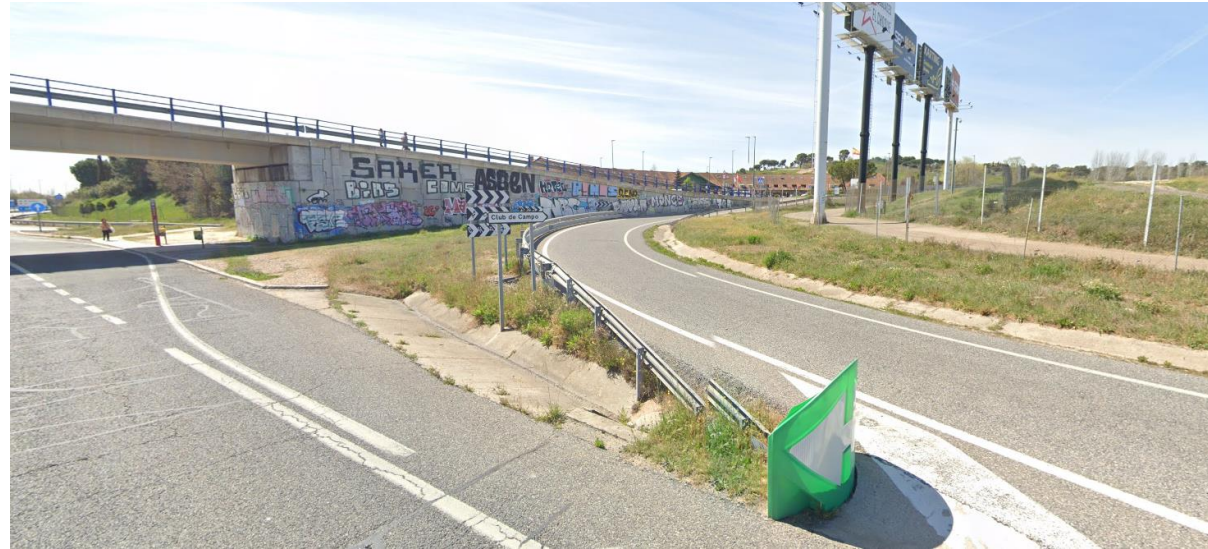
Fotografía 13. PT-8. Entorno de emplazamiento
