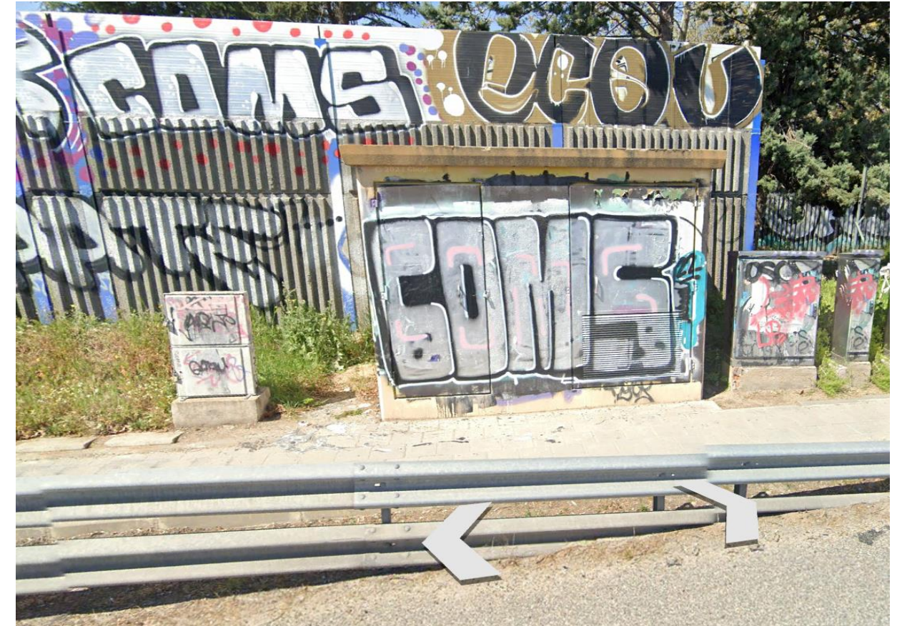
Fotografía 2. PT-1. Extremo final. Elementos eléctricos, pantalla obsoleta y acera existentes
