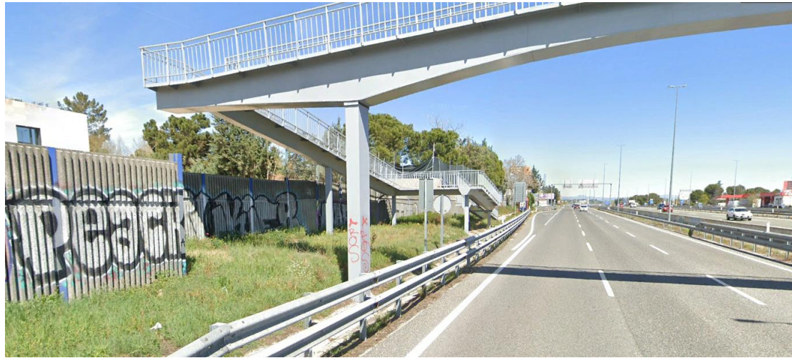
Figura 3. PT-1. Paso junto a pasarela peatonal con pantalla acústica obsoleta existente
