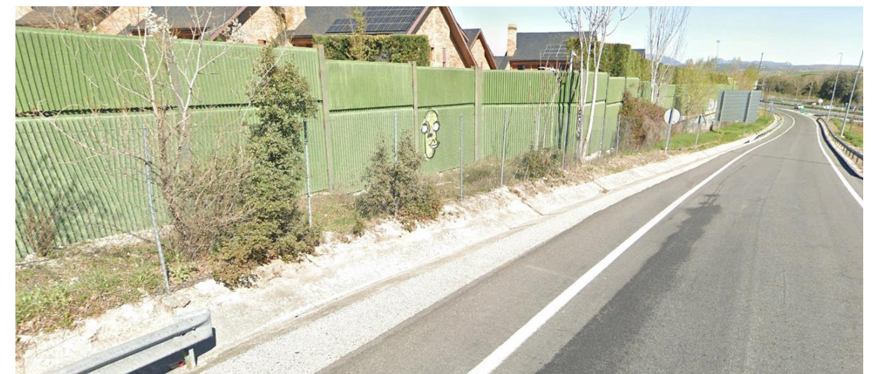
Fotografía 19. PT-12. Tramo inicial en el ramal de enlace sin barrera actualmente
