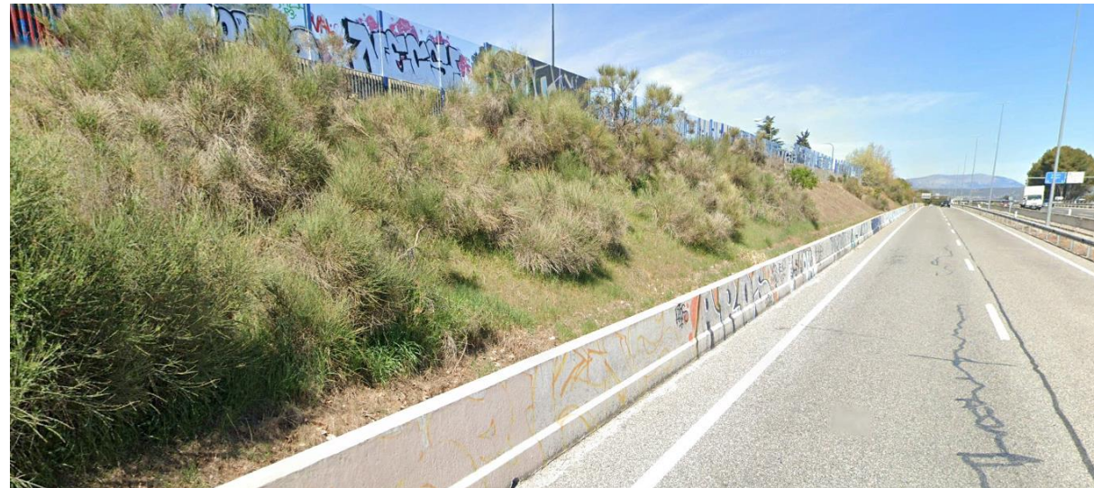
Fotografía 15. PT-10. Pantalla acústica existente
