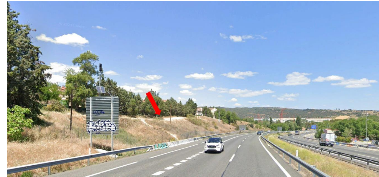
Fotografía 36. PT-18. Cabeza de talud de implantación desde el PK 0+360
