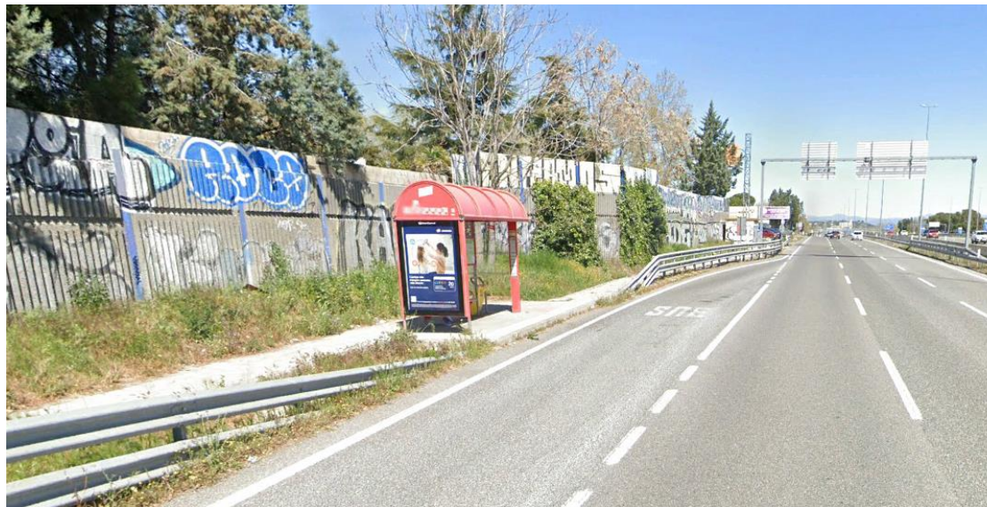
Figura 4. PT-1. Paso por la trasera de parada de autobús con pantalla obsoleta existente
