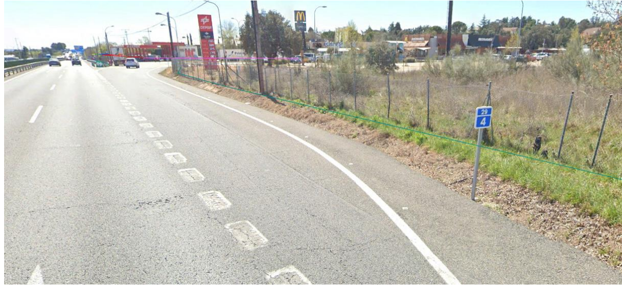
Fotografía 24. PT-14. Vista del tramo en la salida a la estación de servicio
