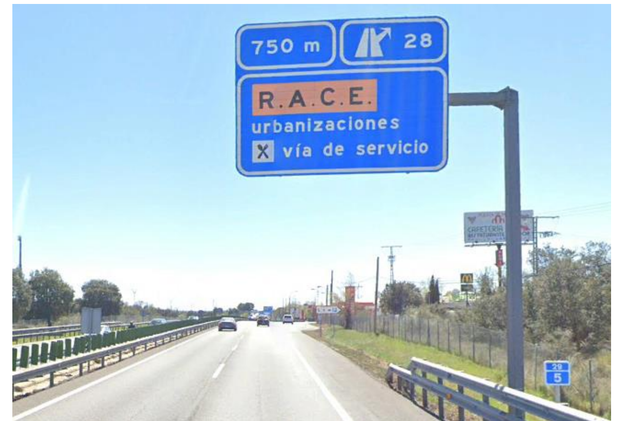
Fotografía 23. PT-14. Entorno general de la pantalla
