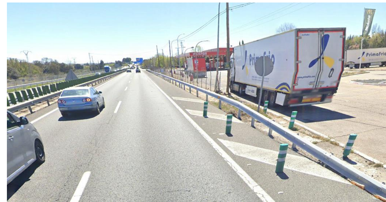
Fotografía 21. PT-13. Emplazamiento. Vista de norte a sur
