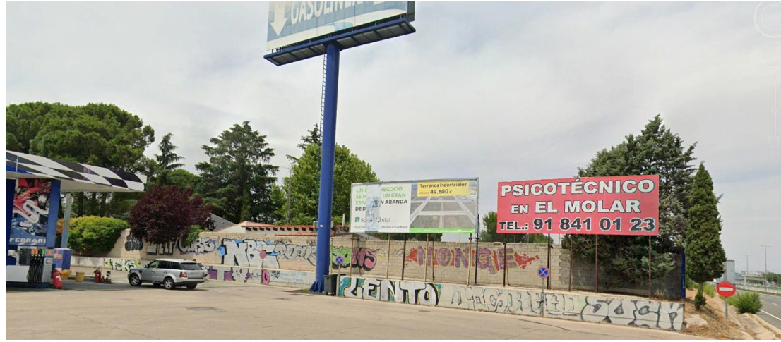
Fotografía 6. PT-4. Tramo inicial en el área de servicio (PP_A-1_24,9_I_MI_1_08)
