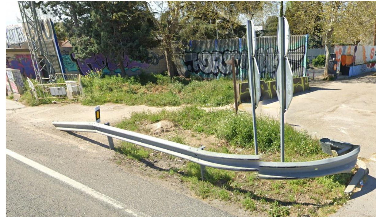
Fotografía 3. PT-2. Entorno de emplazamiento en paralelo a la existente
