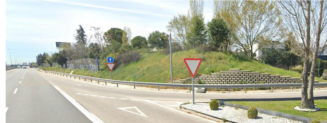
Fotografía 8. PT-4. Tramo final. (PP_A-1_24,9_I_MI_1_10)
