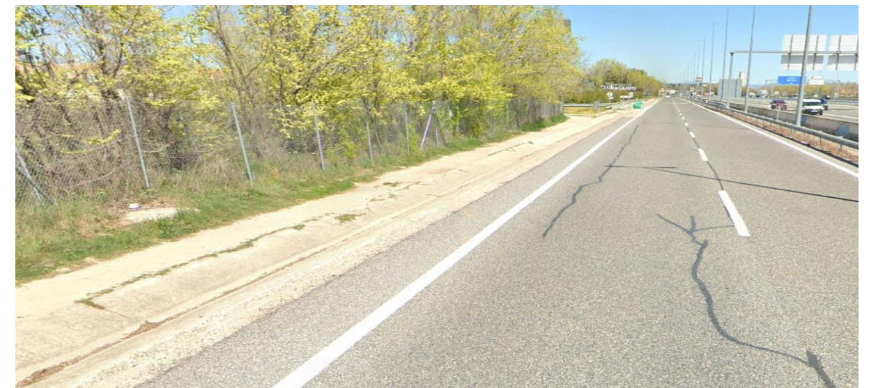
Fotografía 11. PT-6. Entorno de emplazamiento
