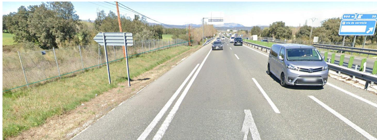
Fotografía 25. PT-14. Vista del tramo en el tronco de la A-1
