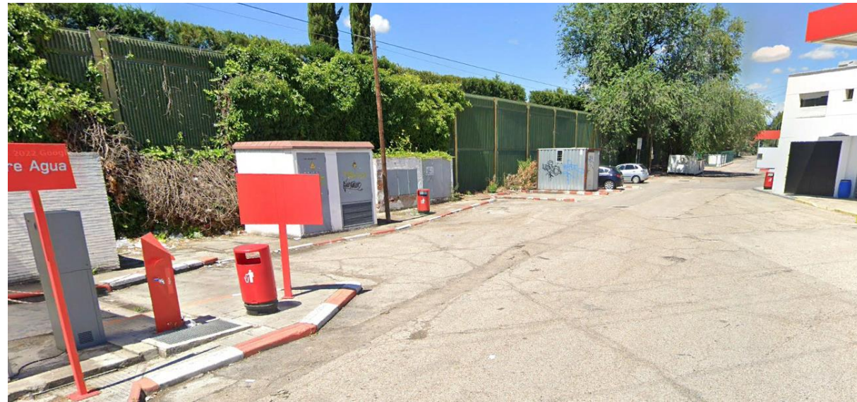
Fotografía 20. PT-12. Tramo final en el recinto del área de servicio
