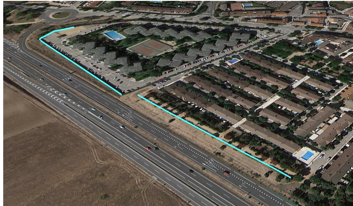
Figura 21. Localización PT-16 -a la izquierda de la imagen- y PT-17. Panorámica
