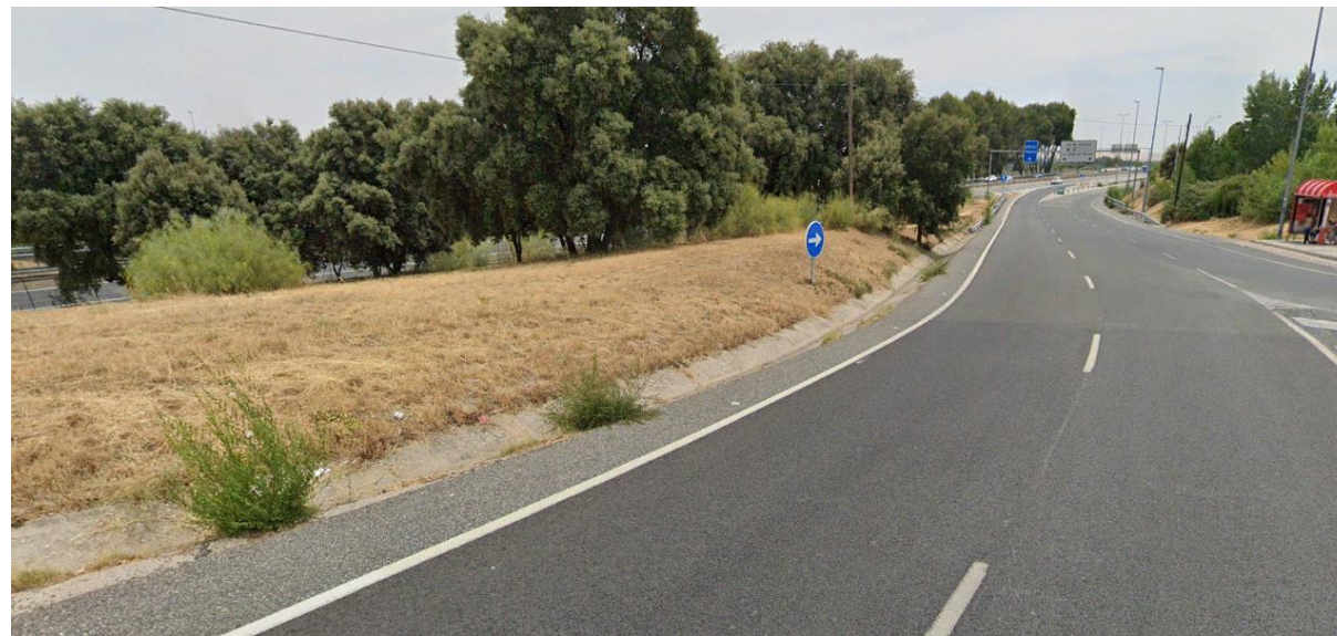
Fotografía 17. Entorno de la pantalla PT-11. No existen barreras de contención.
