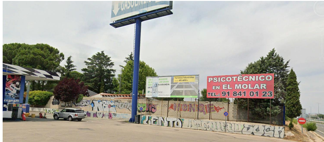
Fotografía 5. PT-4. Tramo inicial en el área de servicio (PP_A-1_24,9_I_MI_1_08)
