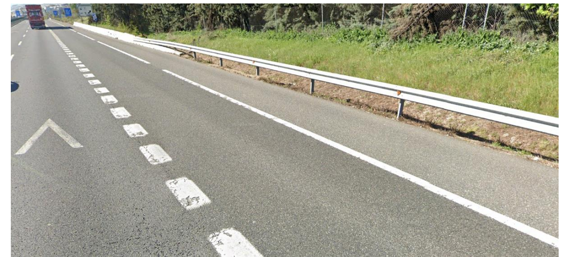
Fotografía 36. PT-18. Barrera metálica en anticipación de barrera de hormigón
