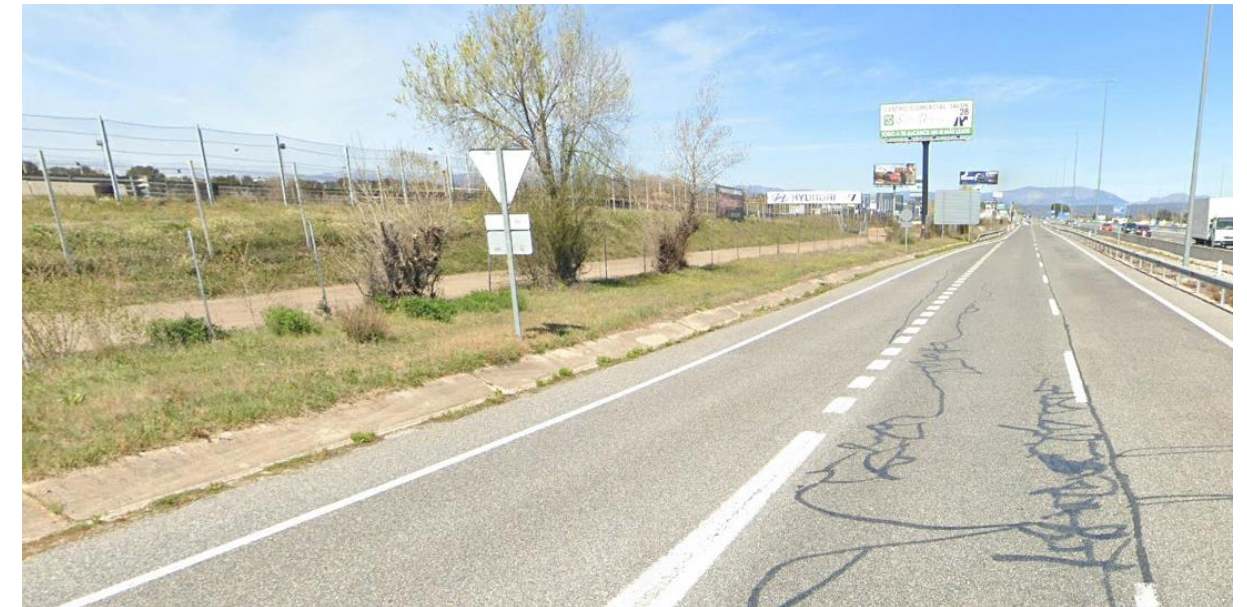
Fotografía 12. PT-9. No existe barrera actualmente
