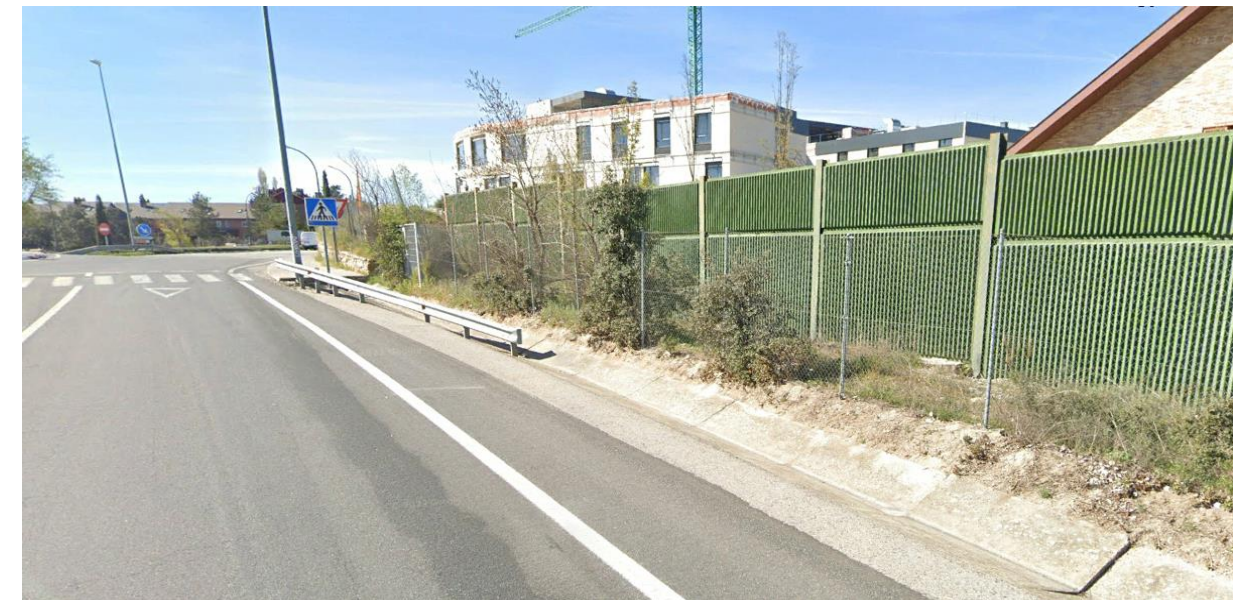
Fotografía 19. PT-12. Barrera existente en el ramal. PK 0+00
