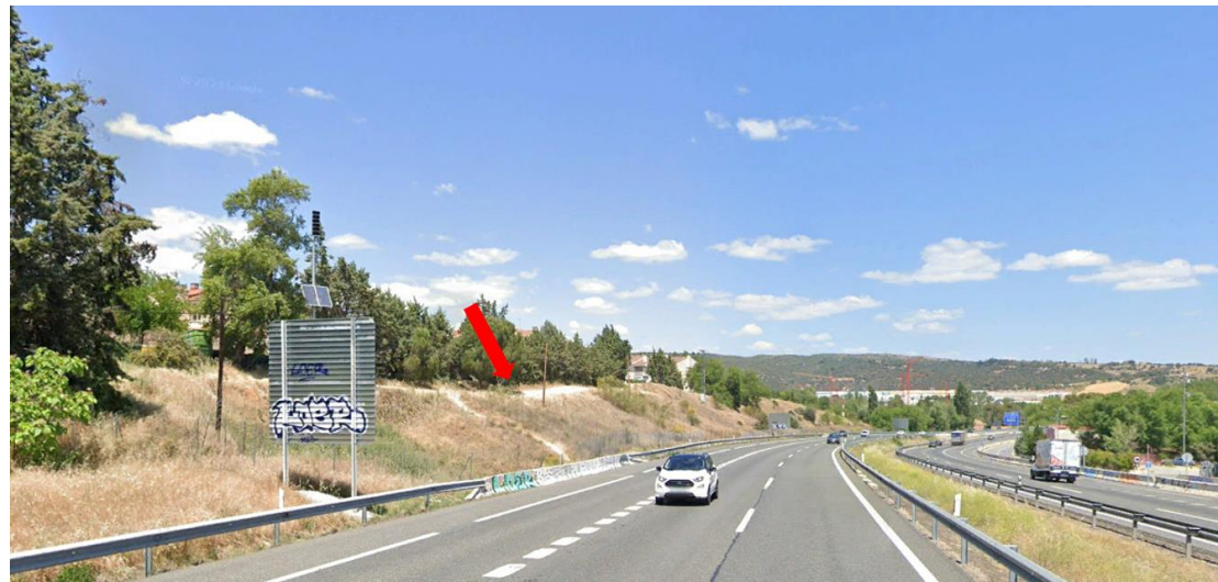
Fotografía 38. PT-18. Cabeza de talud de implantación desde el PK 0+360
