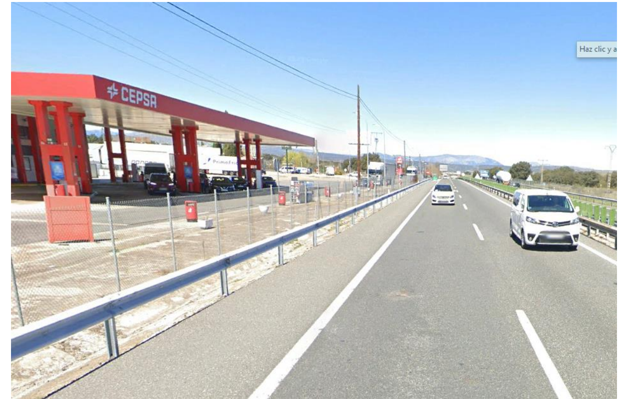
Fotografía 24. PT-13. Emplazamiento. Vista de sur a norte
