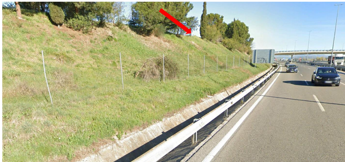
Fotografía 9. PT-7. Entorno de emplazamiento
