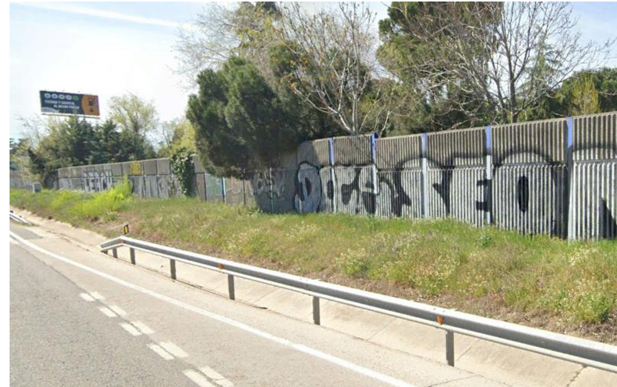
Fotografía 6. PT-4. Barrera metálica existente. Cunetón
