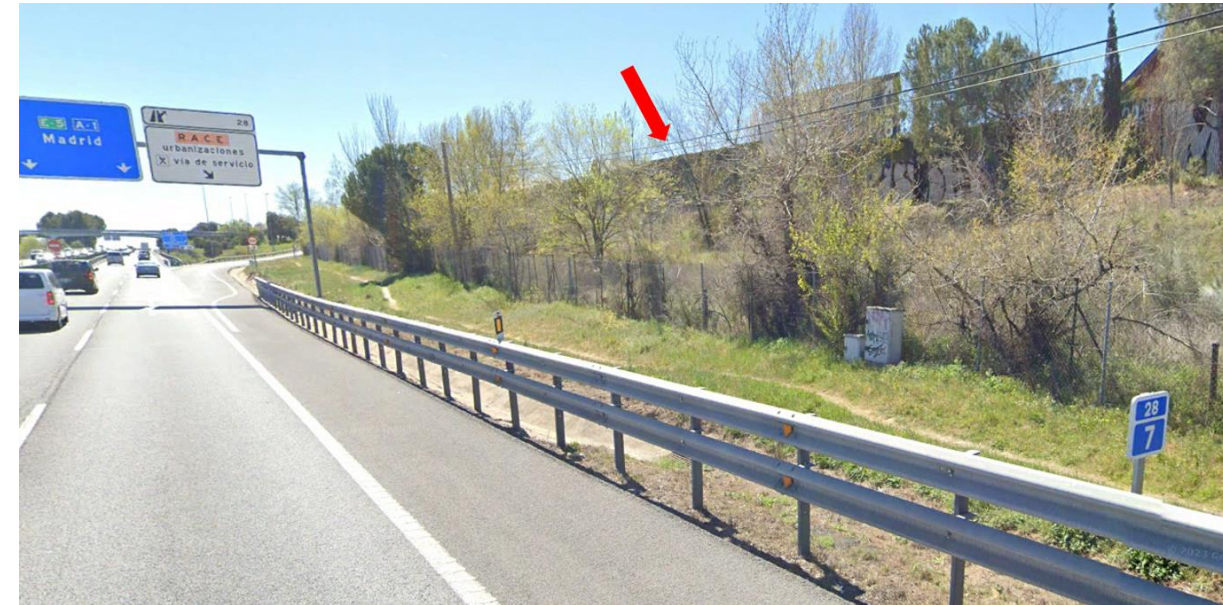
Fotografía 21. Entorno de la PT-12. Pantalla acústica obsoleta a la que discurrirá paralela
