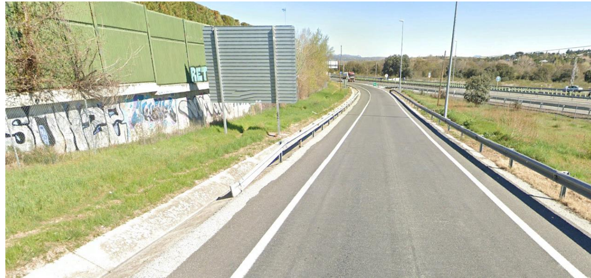
Fotografía 20. PT-12. Barrera existente en el ramal. PK 0+100
