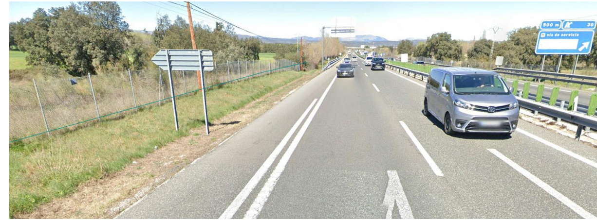
Fotografía 27. PT-14. Vista del tramo en el tronco de la A-1
