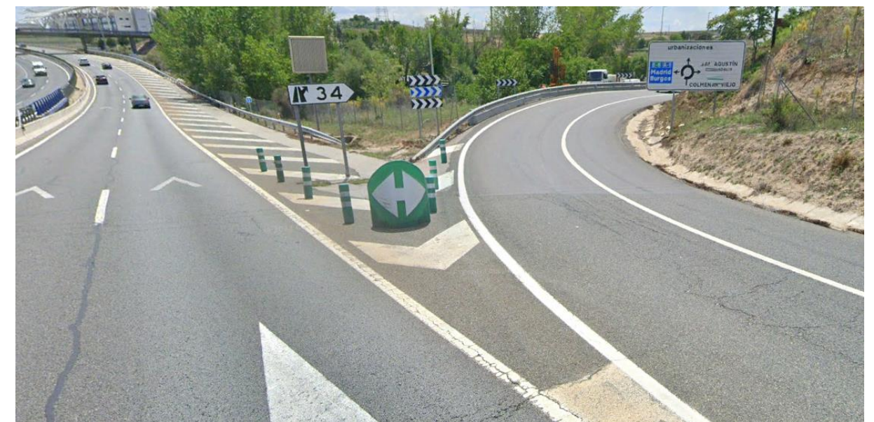
Fotografía 31. PT-15. "Nariz" a proteger con amortiguador de impacto
