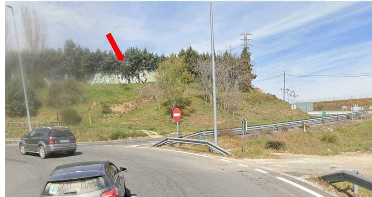
Fotografía 32. PT-16. Ramal de salida. Pantalla acústica obsoleta a la que discurrirá paralela
