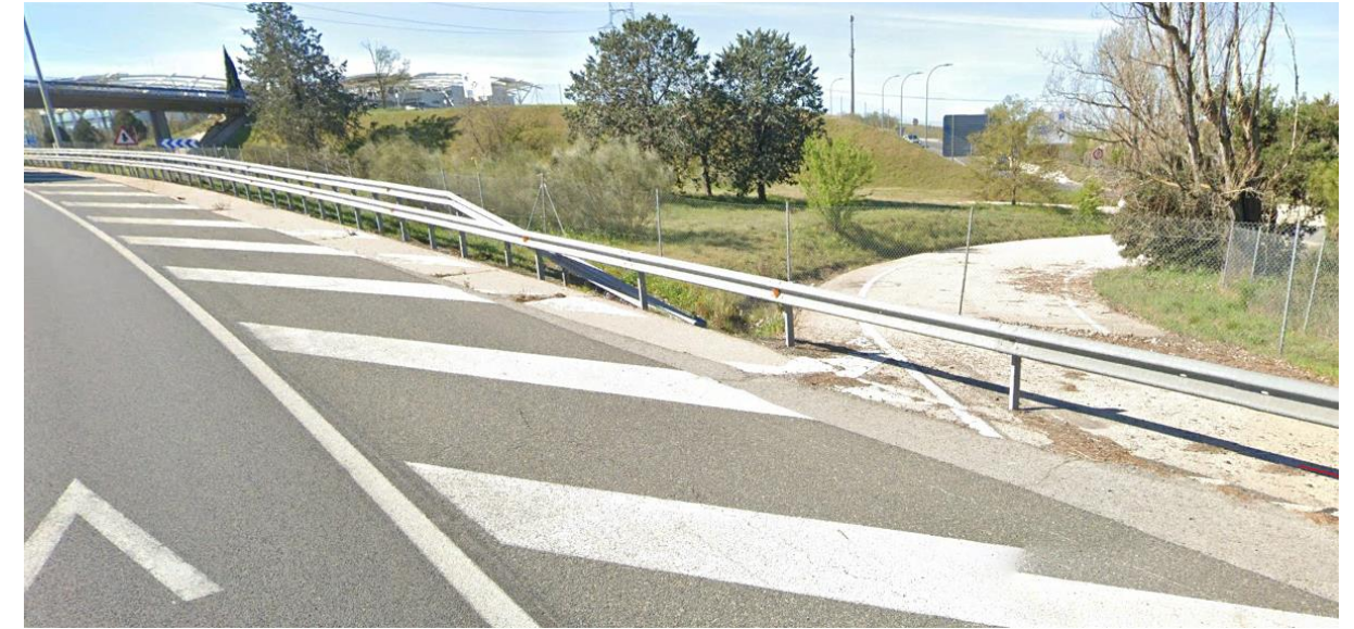
Fotografía 30. PT-15. Barrera existente al sur de la pantalla para protección de colisión con el viaducto
