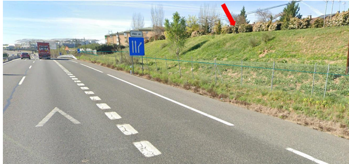
Fotografía 34. PT-17. Coronación de talud en que irá ubicada
