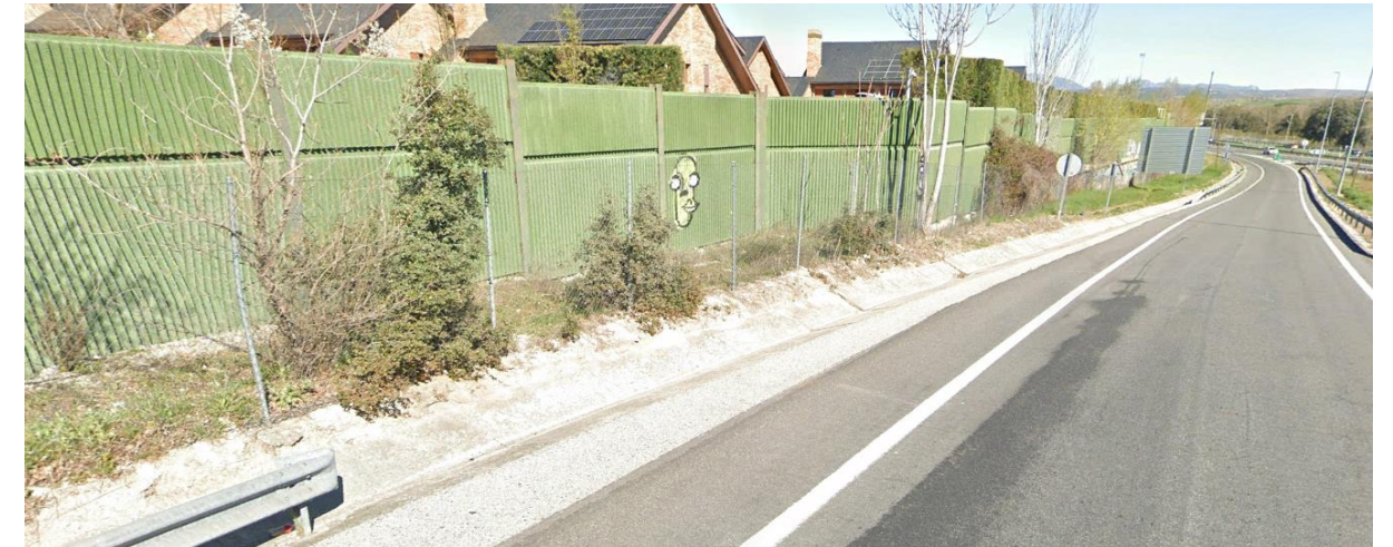
Fotografía 18. PT-12. Tramo inicial en el ramal de enlace sin barrera actualmente
