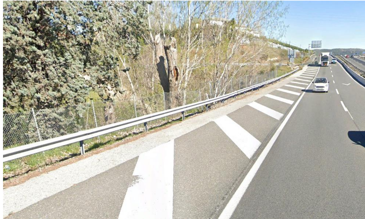
Fotografía 28. PT-15. Barrera existente en toda su longitud
