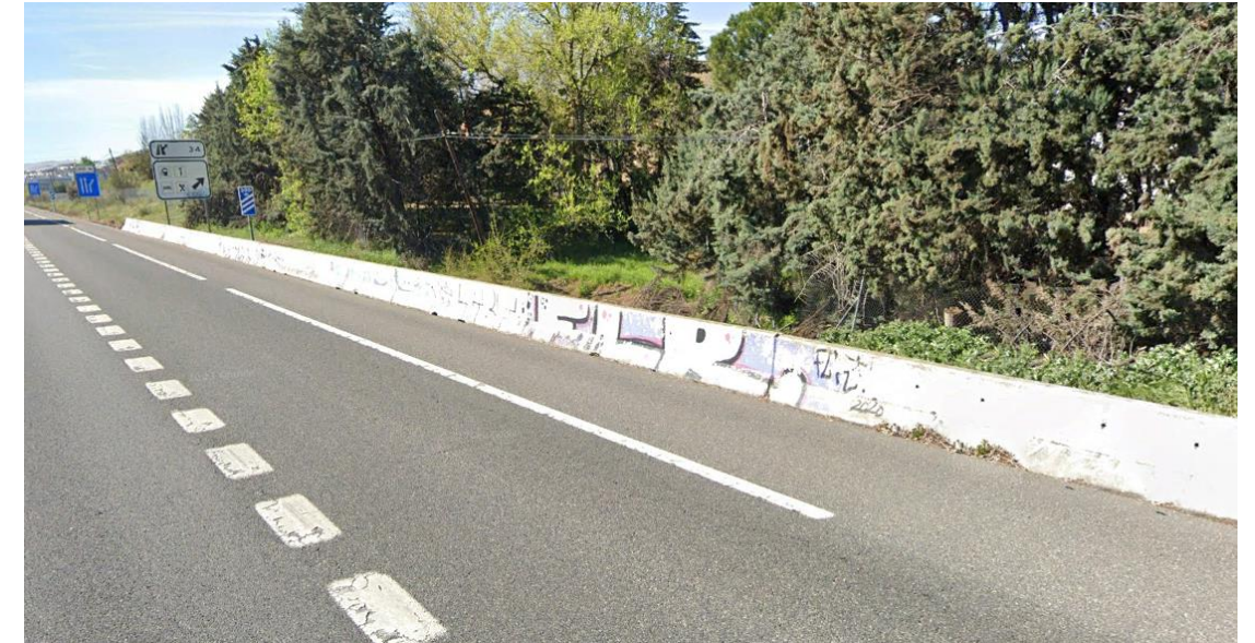
Fotografía 35. PT-18. Barrera tipo New Jersey existente en la zona inicial
