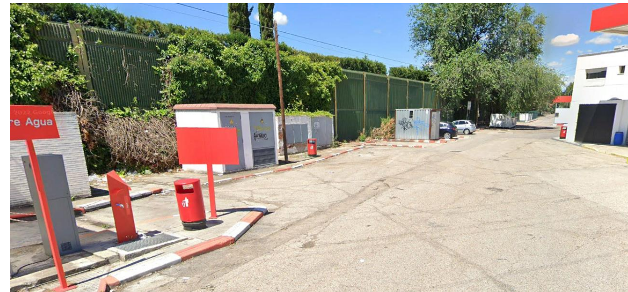
Fotografía 22. PT-12. Tramo final en el recinto del área de servicio
