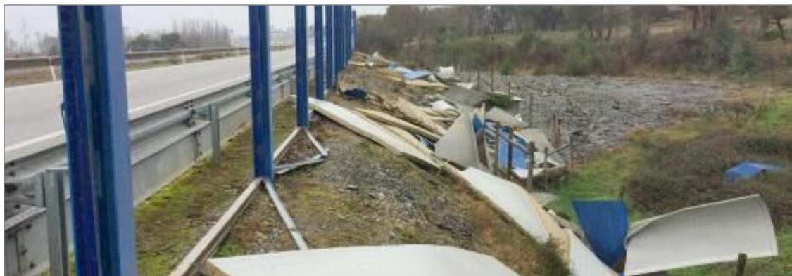
Fotografía 3. Reparación de paneles deteriorados.
