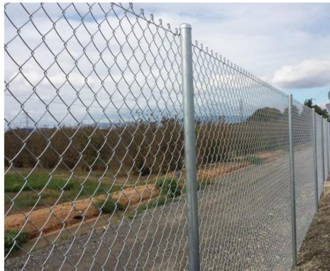
FIGURA 14. Ejemplo cerramiento metálico temporal de obra
