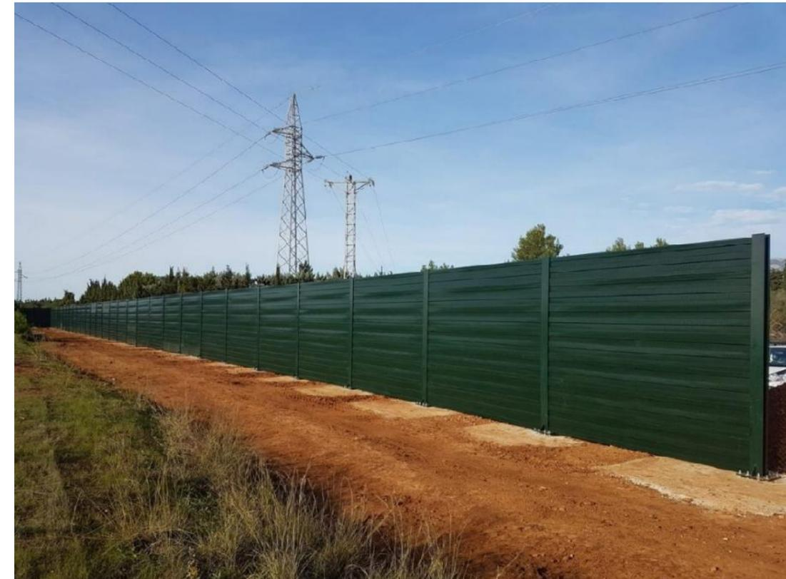
FIGURA 1. Ejemplo de solución con pantallas acústicas metálica en un tramo de carretera
