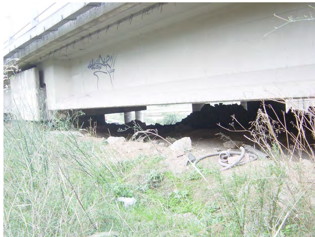
Detalle de apoyo de vigas sobre pila 8.
