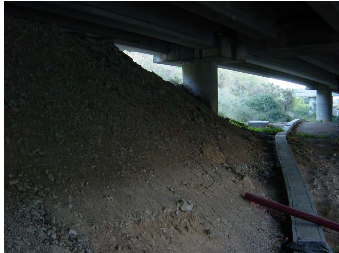
Vista hacia Molins bajo el tablero de los vanos 7 y 6.
