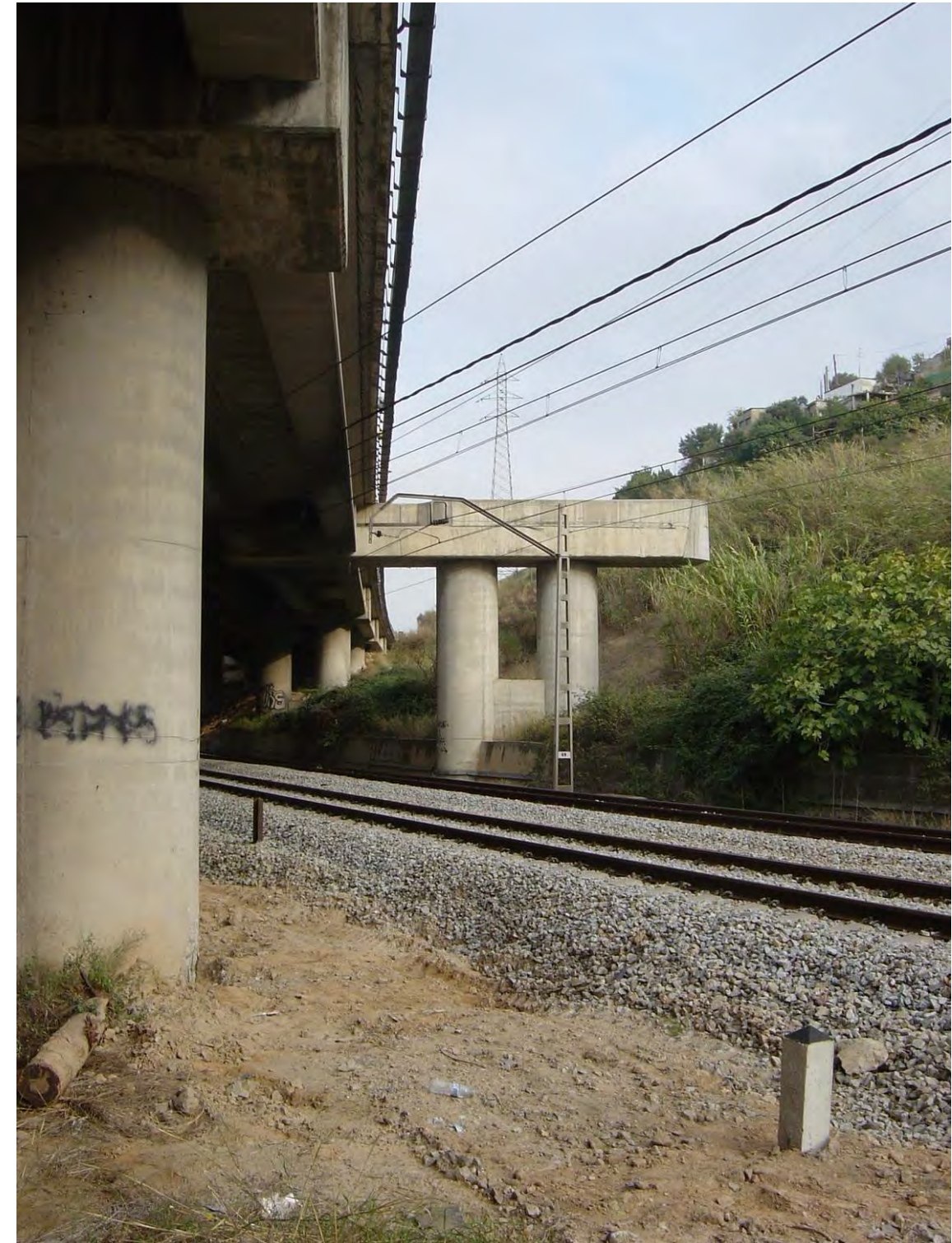
Vista del vano 4 hacia el norte. Entre las pilas 4 y 5 cruza el ferrocarril.
