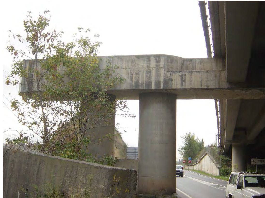
Detalle de la Pila 2 vista desde el vano 3 hacia el sur.
