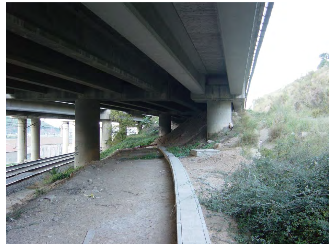
Vista por debajo del vano 6 hacia el estribo 2 (estribo norte)
