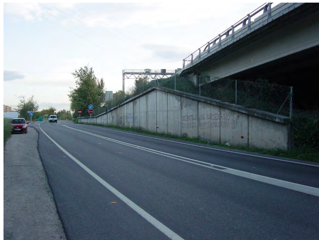
Muro de Aleta lado Molins estribo 1
