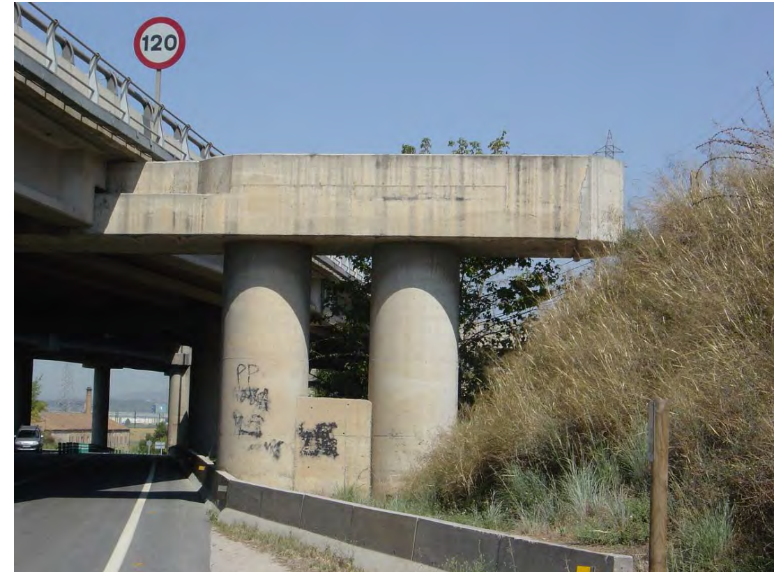
Pila 2 vista desde el vano 1 hacia el norte.
