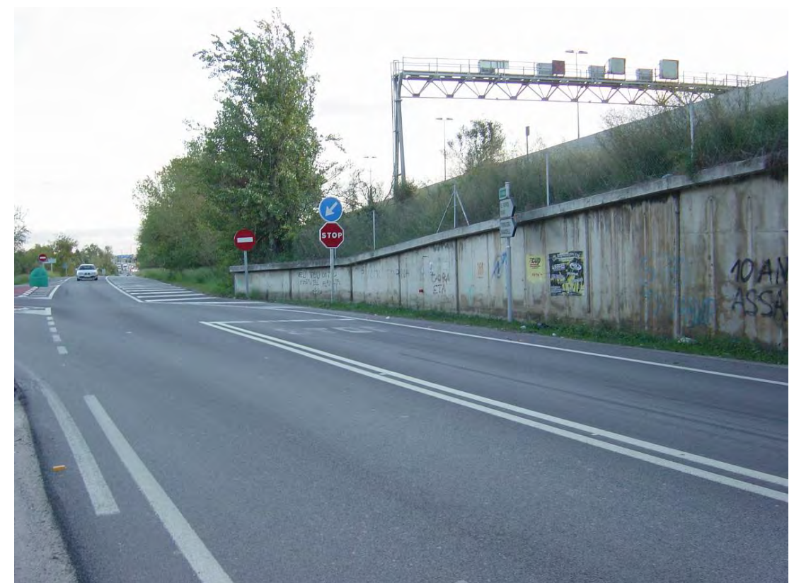
Detalle del final del muro de Aleta estribo 1 lado Molins
