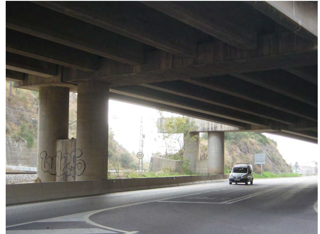
Vista hacia Molins de las pilas 4 y 3 (pórtico).
