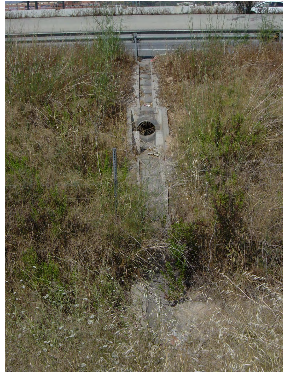
DESAGUE DE MEDIANA \phi = 40 CM A LA IZQUIERDA DEL MARCO
