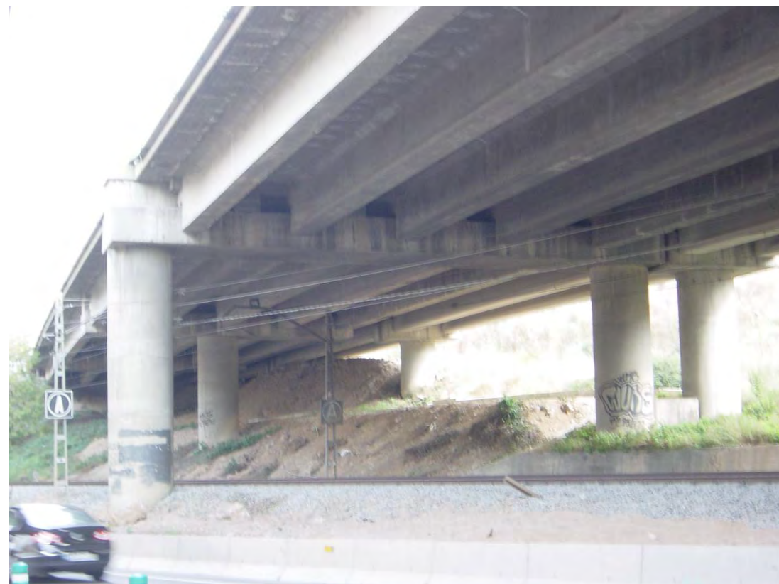
Vista hacia el lado Molins, bajo el vano 5, de la pila 6 hacia el estribo 2.
