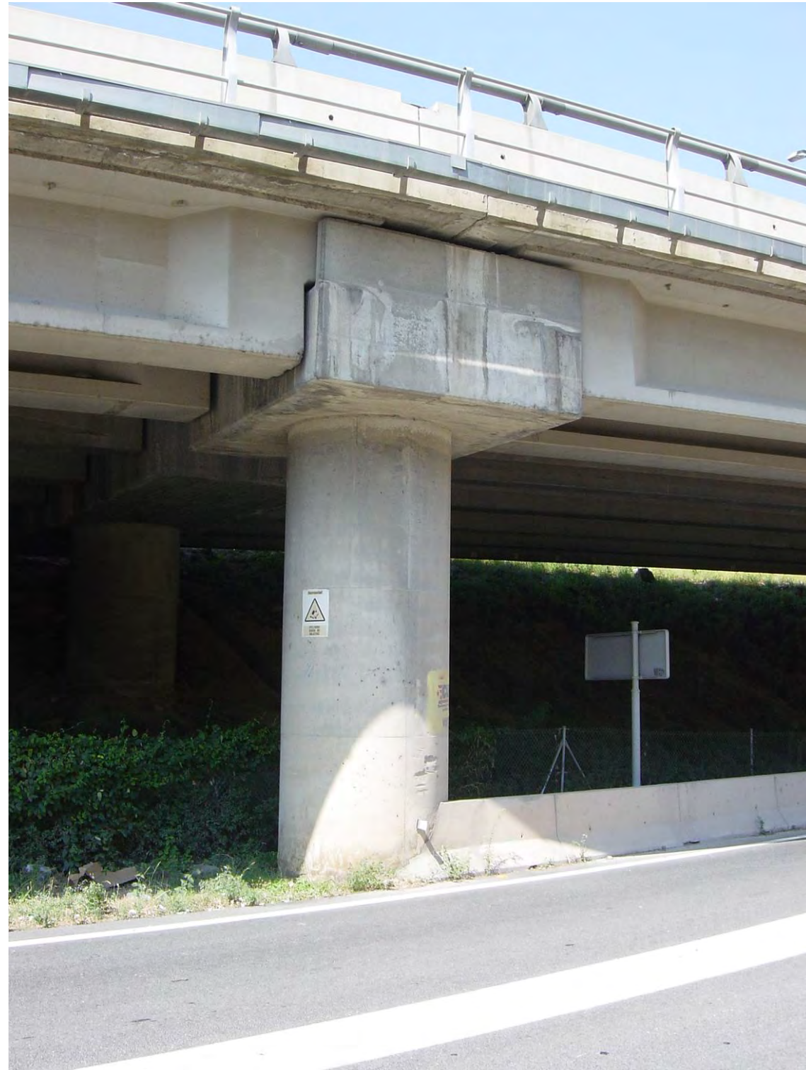
Pila 1 vista desde el lado Molins
