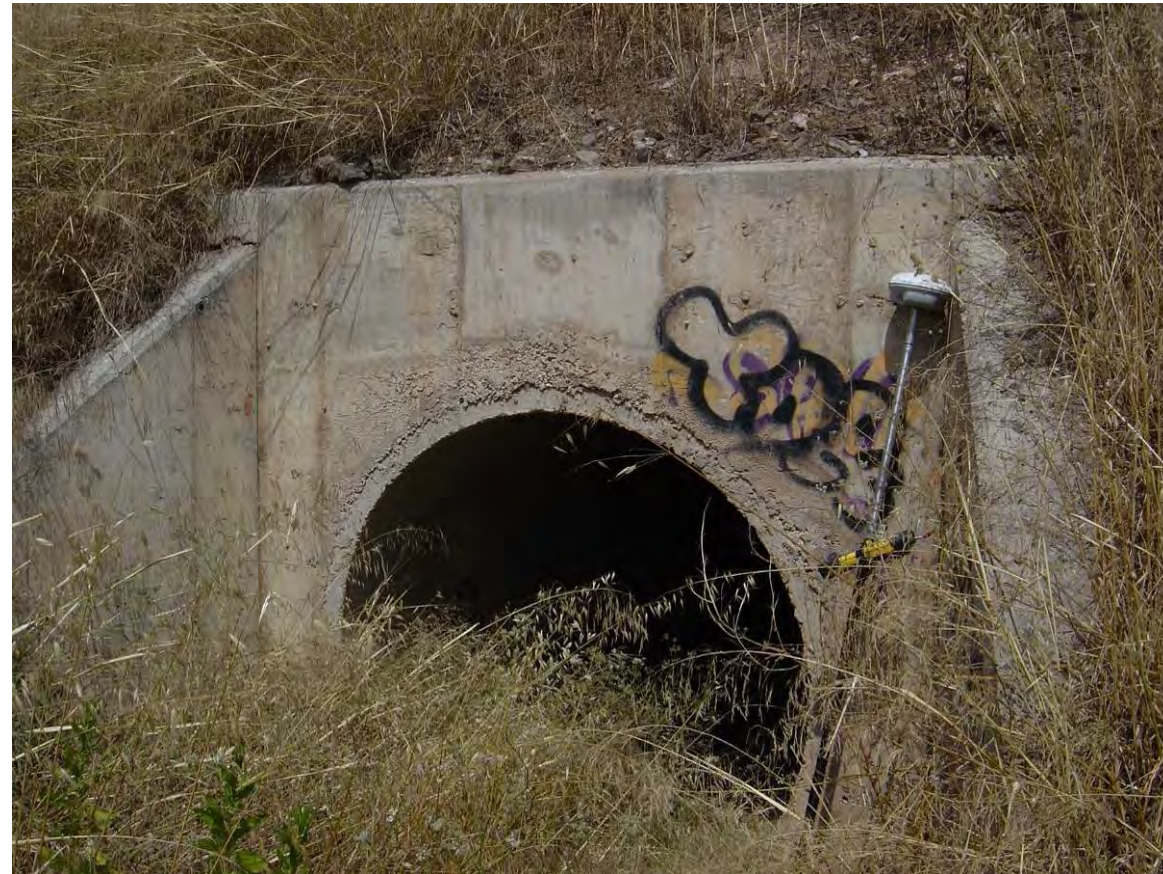
Margen izquierda (entrada en ramal existente Pallejà-Cervelló)
