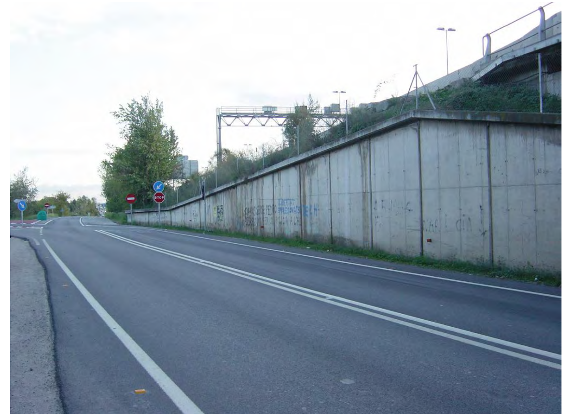
Muro de Aleta lado Molins estribo 1
