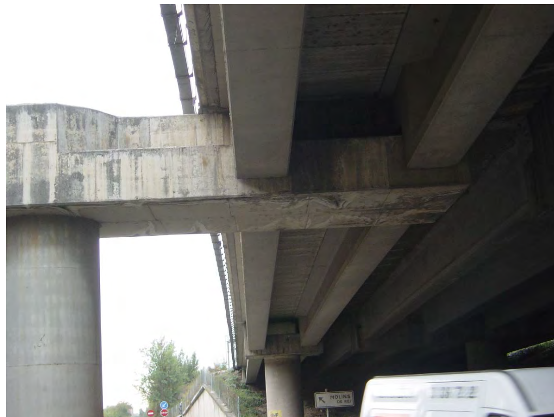
Cargadero de la Pila 2 vista por debajo desde el vano 3 hacia el sur.
