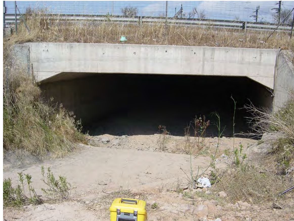
ACTUACIÓN B MARCO RAMAL 1 P.K 1+800 (LADO PALLEJÁ)
