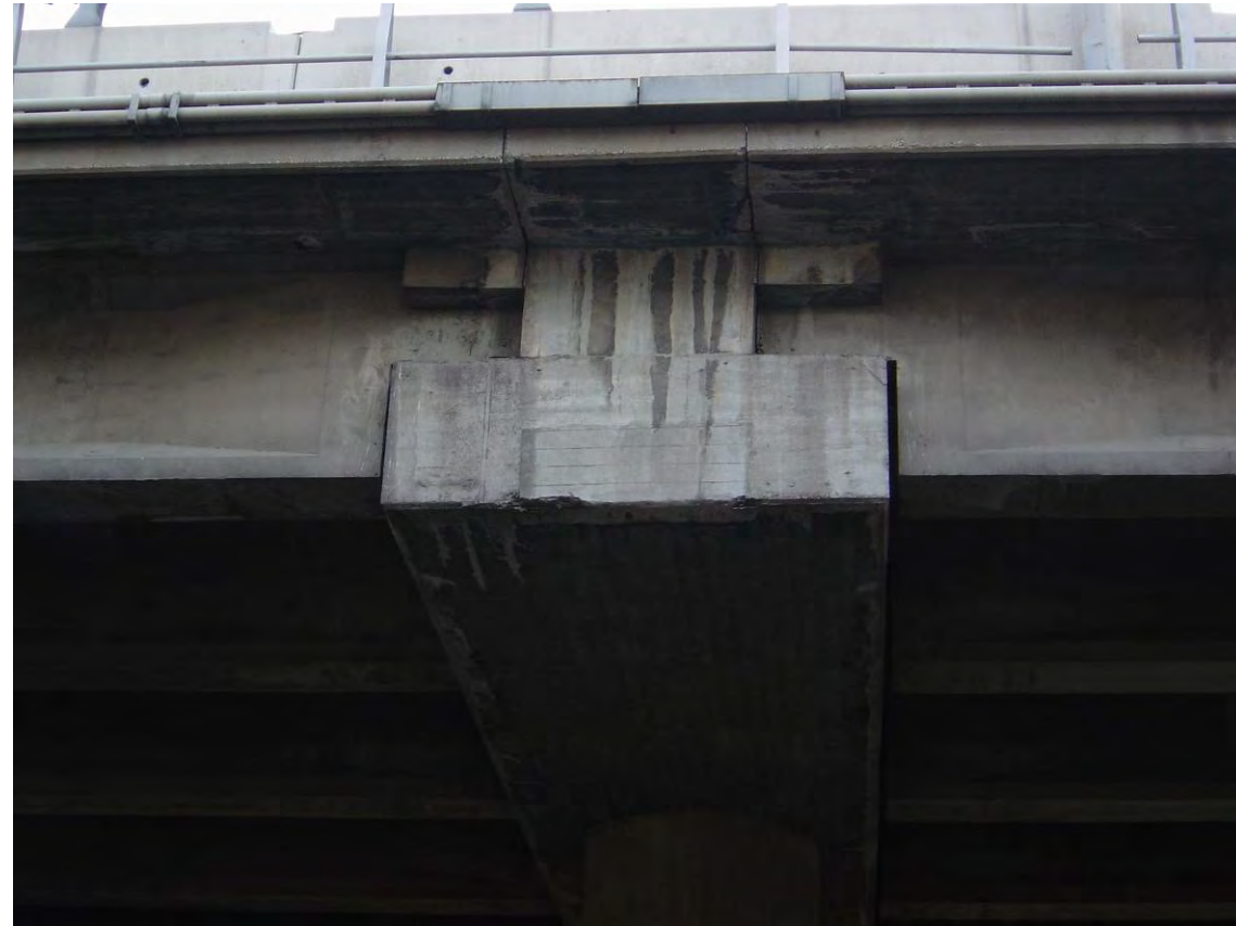
Detalle de apoyo de las vigas sobre la pila 4.
