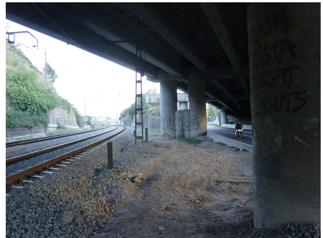
Vista bajo el vano 4 hacia el sur.
