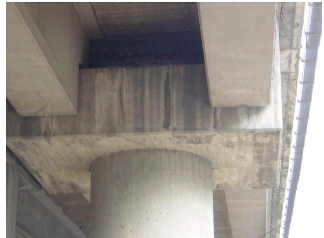
Detalle de capitel de la Pila 1. Se empleó el tablero de 5 a 7 vigas.
