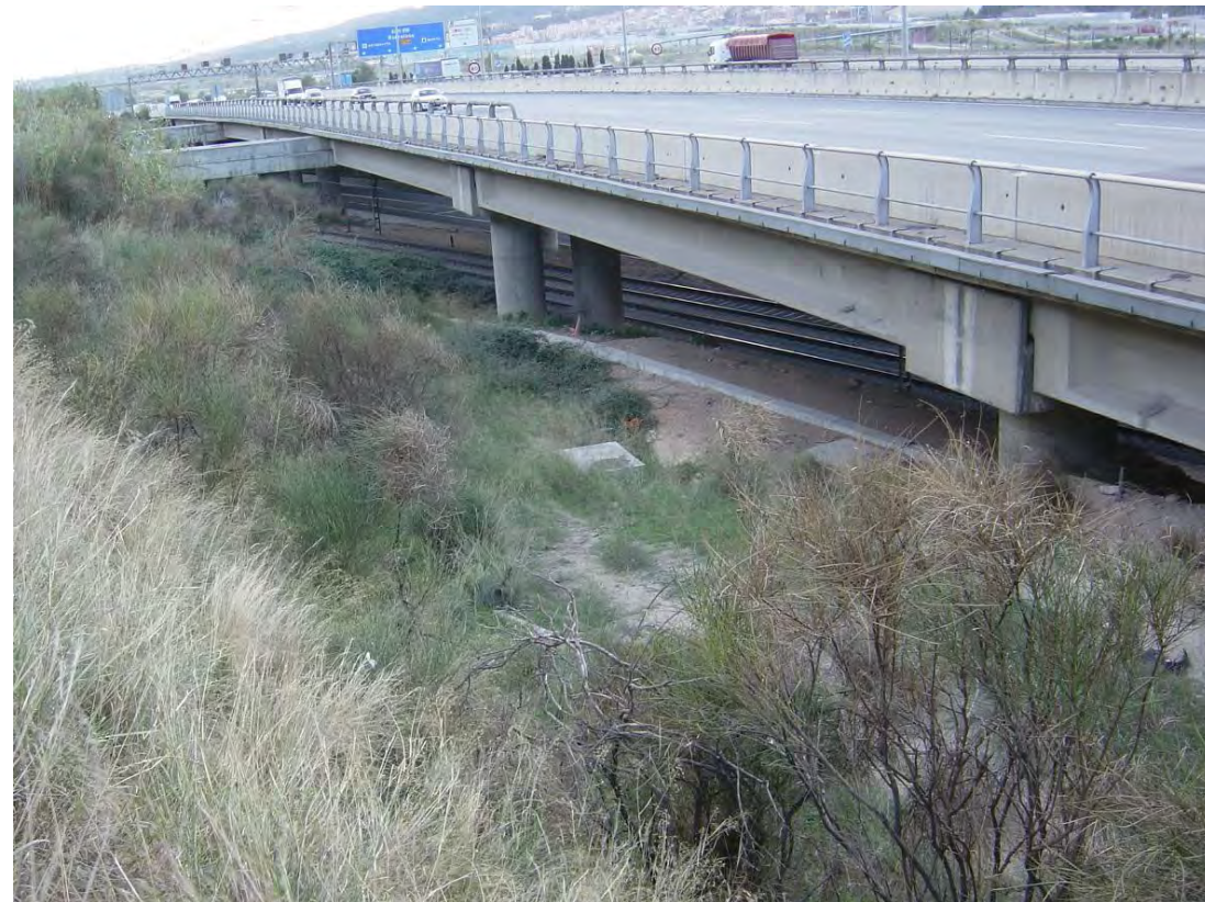
Vista general hacia el sur desde la pila 8 por el lado Molins.
