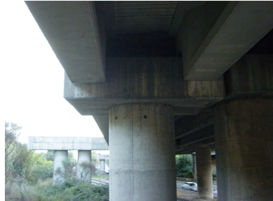
Vista bajo el vano 6 hacia el estribo 1 (estribo sur). Detrás a la izquierda se ve el pórtico de la pila 5.
