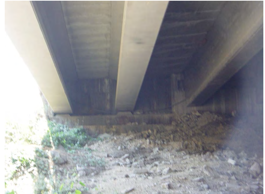
Otra vista del Estribo 1 (estribo sur) bajo el tablero a ampliar.
