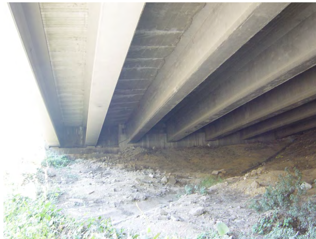
Estribo 1 (estribo sur) del tablero a ampliar. Ya hubo una ampliación de 5 a 7 vigas
