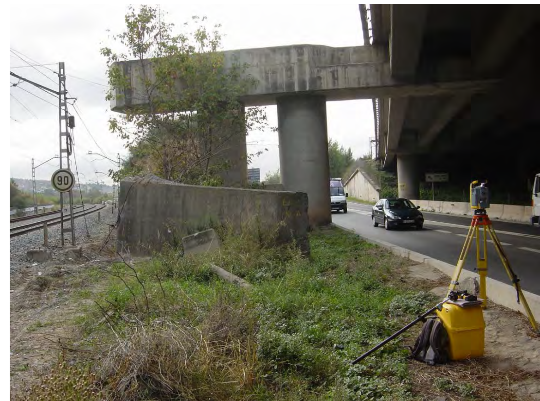
Pila 2 vista desde el vano 3 hacia el sur.
