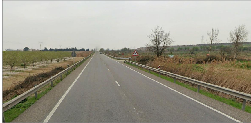
Fotografía 1. Sección N-240 en terraplén
