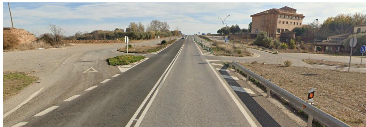
Figura 27. Intersección a nivel con giros peligrosos
