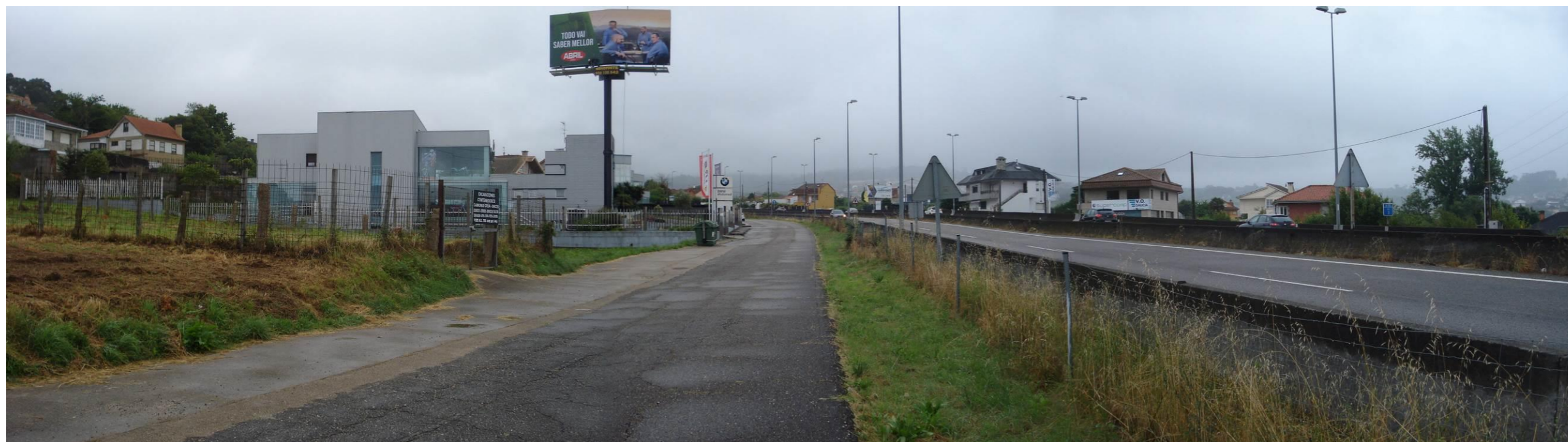
Vista en dirección Sur. Fincas con matorral entre viviendas próximas a la A-55.
