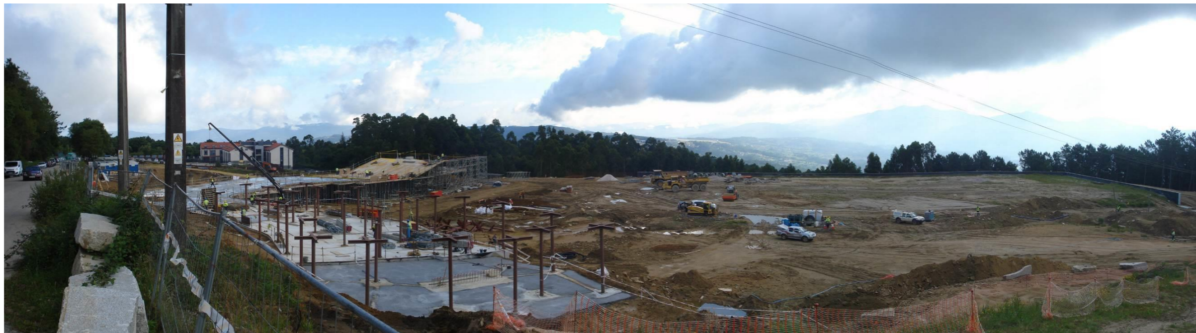
Vista en dirección E. Construcción de instalaciones deportivas en el campo de fútbol.
