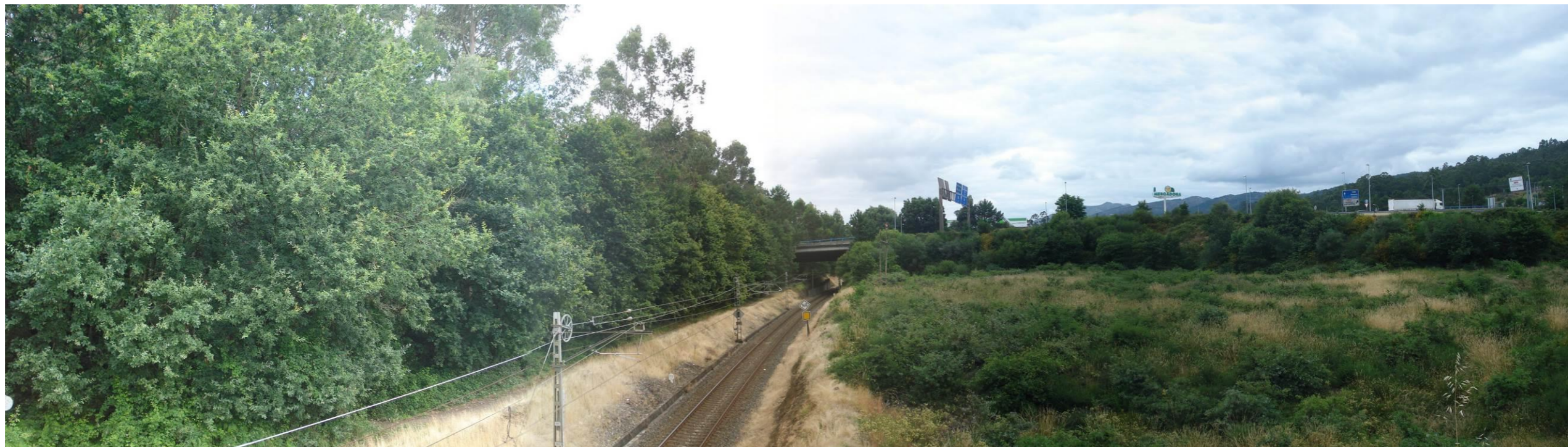
Vista en dirección N. A la derecha de la vía del tren, matorral y sauces en el talud de la A-55. A la izquierda de la vía, masa de carballo con ejemplares intercalados de eucalipto.
