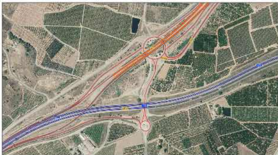
Vista entorno de ubicación de la estación de recarga
