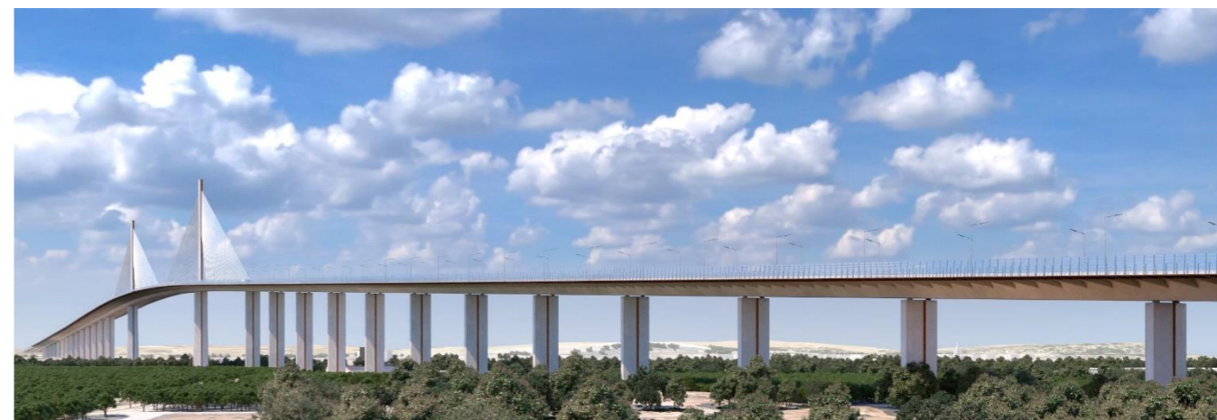
Imagen 50. Vista del tramo atirantado y de los viaductos de acceso
