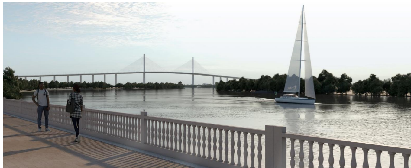
Imagen 43. Vista del puente desde Coria
