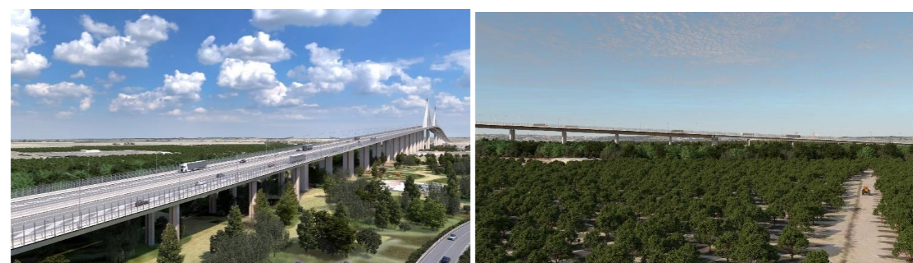
Imagen 51. Vista de la zona transición entre el viaducto de aproximación este y el viaducto principal
