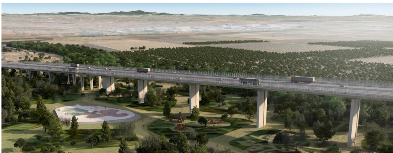
Imagen 7. Vista del parque en la zona transición entre el viaducto de aproximación este y el viaducto principal.
