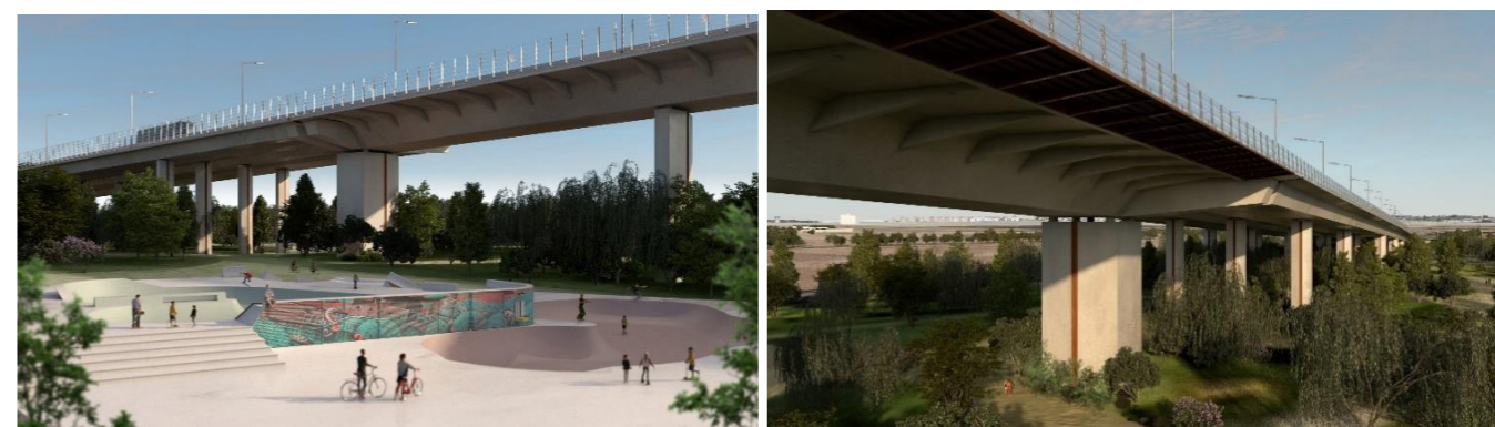
Imagen 99. Vistas del parque en la zona transición entre el viaducto de aproximación este y el viaducto principal
