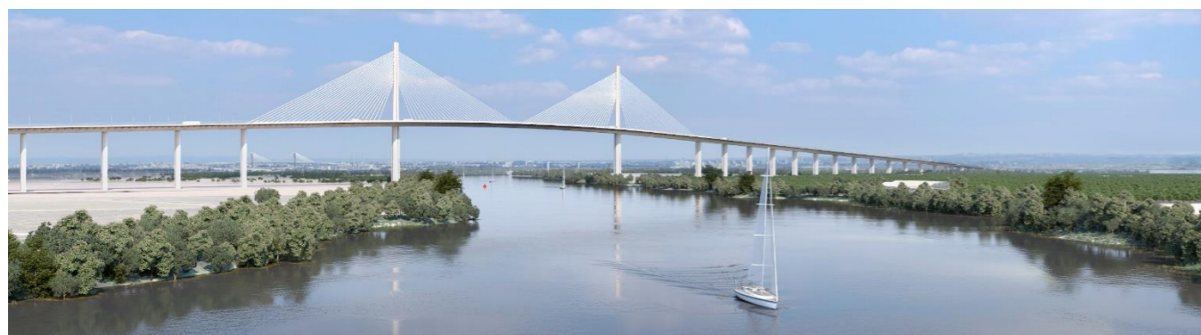
Imagen 49. Imagen del tramo atirantado y los viaductos de acceso
