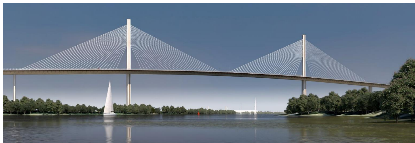
Imagen 48. Imagen del tramo atirantado
