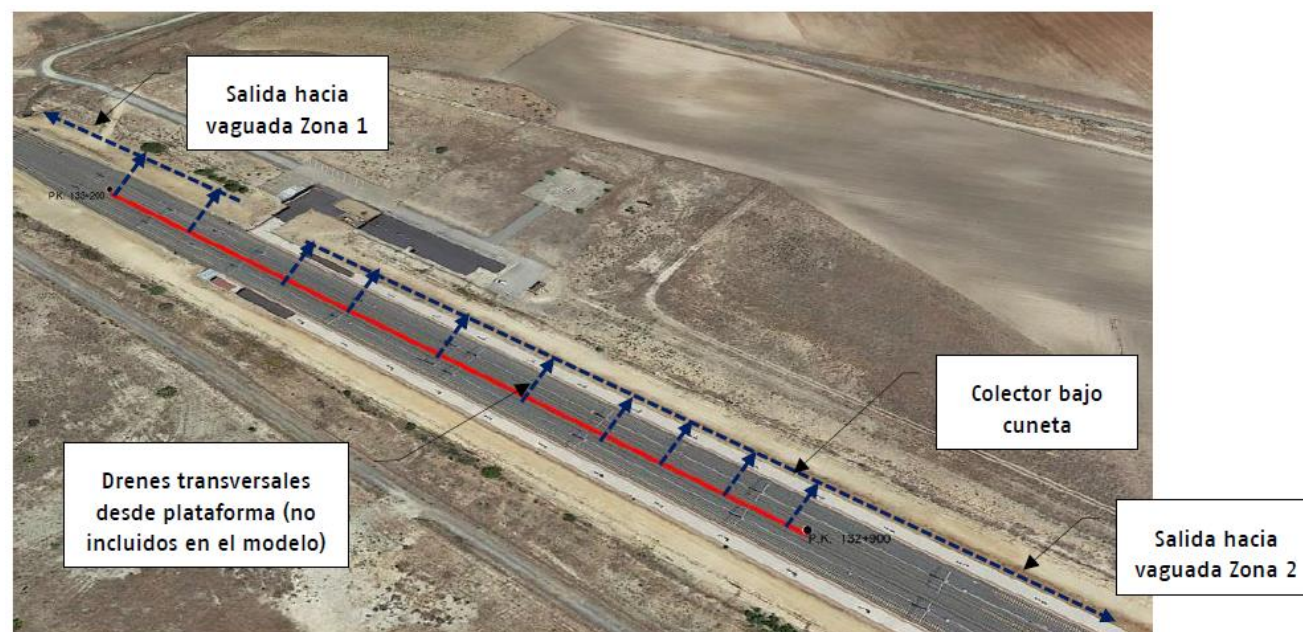
Figura 3.- Zona de visita proyecto 1.c. Elementos detectados en visita de campo
