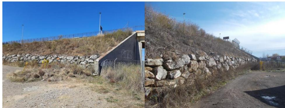
Fotos 4 y 5: vista del muro de escollera existente en la zona del futuro muro 2.
