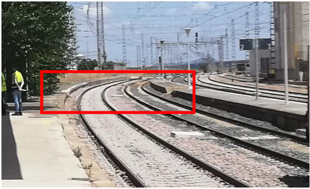
Ilustración 3 – Detalle paso entre andenes desmantelado – Estación de la Roda de Andalucía
