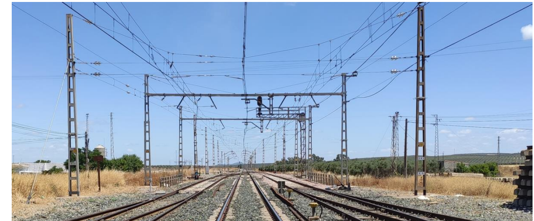
Ilustración 4 – Pórticos rígidos en cabecera – La Roda de Andalucía
