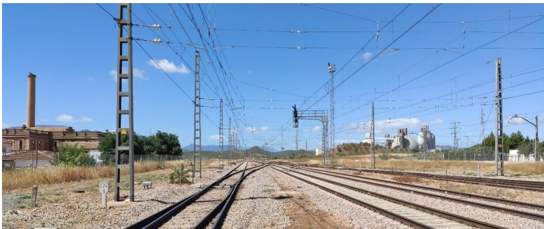
Ilustración 15 – Pórticos flexibles funiculares – Bobadilla
