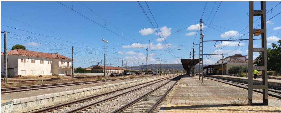
Ilustración 14 – Semipórticos rígidos vías I y III en andenes – Bobadilla
