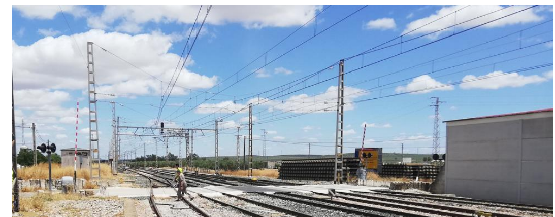
Ilustración 5 – Pórticos flexibles funiculares – La Roda de Andalucía
